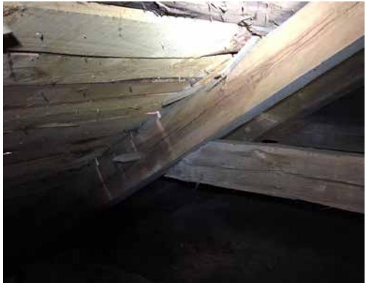
I den östra taksvallen fanns en sentida lagning. Takstolarna var ihopsatta med dymlingar.
