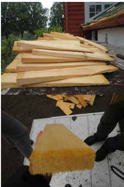
Den nya täckningen utfördes med kluvna kärnfuruspån av hög kvalitet.
