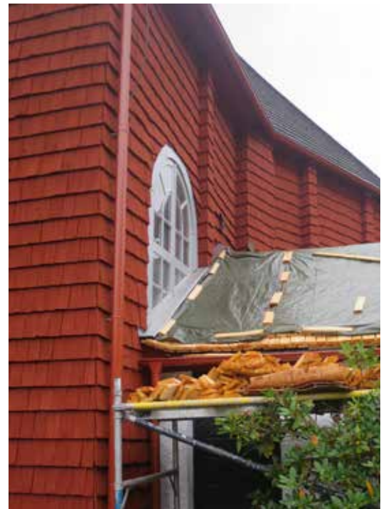
Avslutningsplåten mot fasaden är av kopparplåt. Den är målad i grått under fönstret.
