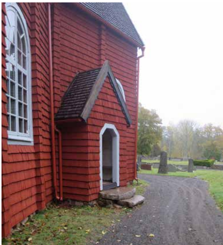
Del av kyrkans södra fasad efter ommålning.
