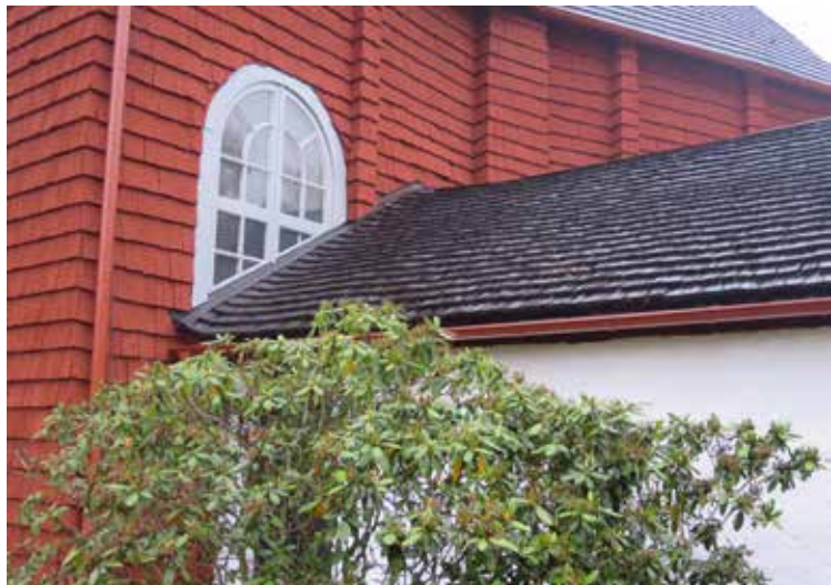
Sakristians tak med ny täckning av kluven kärnfuruspån behandlad med dalbränd furutjära. Anslutningslisten mot fasaden målades svart istället för grå som tidigare, detta för att erhålla ett mer enhetligt utseende.
