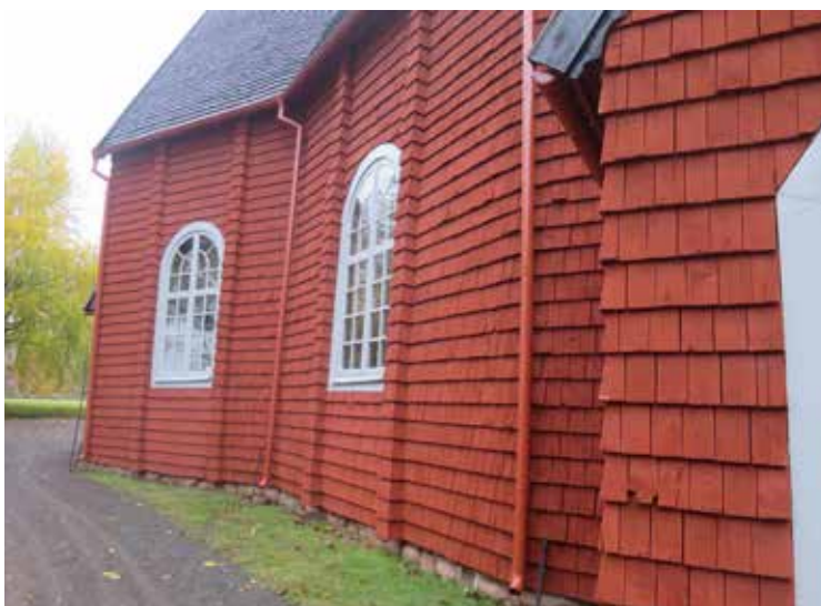
Kyrkans södra fasad med den nya takavvattningen.
