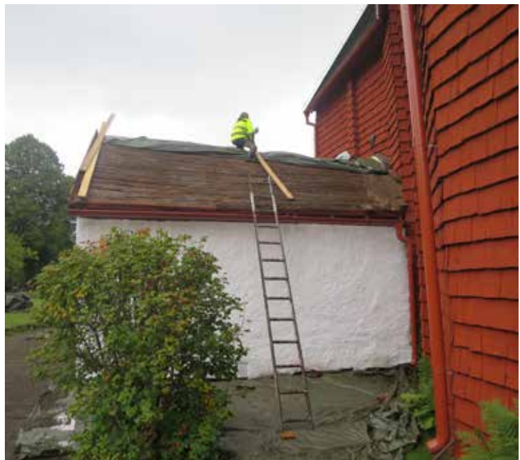
Västra takfallet på sakristian efter att spåntäckningen rivits (till höger). Igensättningen i västra takfallet med ramsågad bräda (ovan).
