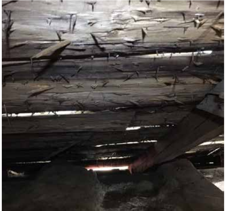
Insidan av taksvallen på västra takfallet, vilken var av kluvna brädor och hade mängder av äldre spånspik.
