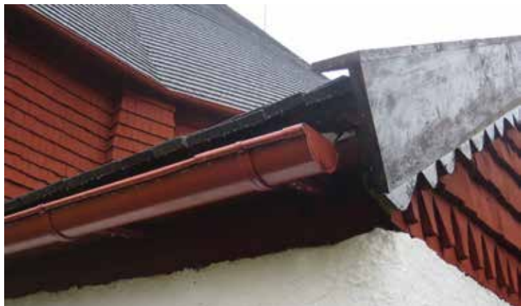
Sakristians tak med ny täckning av kluven kärnfuruspån behandlad med dalbränd furutjära. Anslutningslisten mot fasaden målades svart istället för grå som tidigare, detta för att erhålla ett mer enhetligt utseende.
