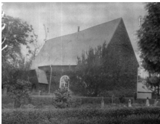
Foto från 1927 då spåntaken åter lagts om. Nu har nya stuprör med skarprörsvinklar satts upp. Antagligen fungerade de föregående bristfälligt. Fotograf William Andersson, ATA.
