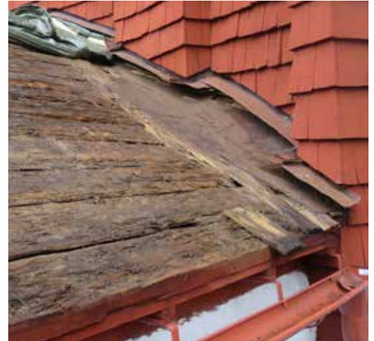
Takpappen mot fasaden täcktes med björknäver. Nedre taksvallsbrädan var bearbetad med yxa i kanten.
