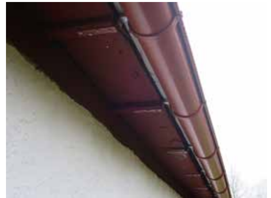
Detalj av hängränans infästning på sakristian.
