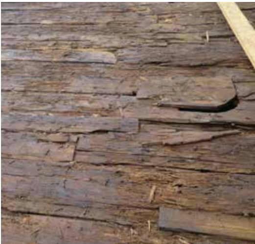
Västra takfallet på sakristian efter att spåntäckningen rivits (till höger). Igensättningen i västra takfallet med ramsågad bräda (ovan).
