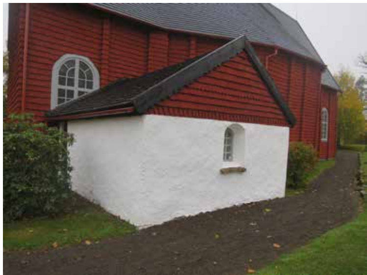
Sakristian med omlagt spåntak, ny takavvattning och ommålad.
