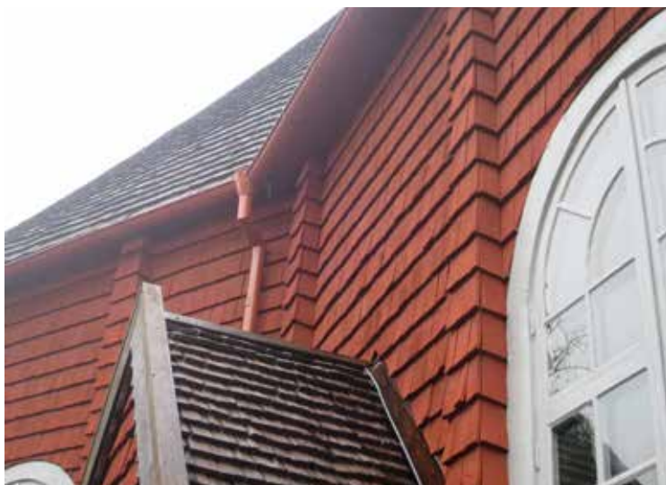
Ny fabriktillverkad och lackerad takavvattning på kyrkan med samma typ av trattar och skarprörsvinklar som tidigare.
