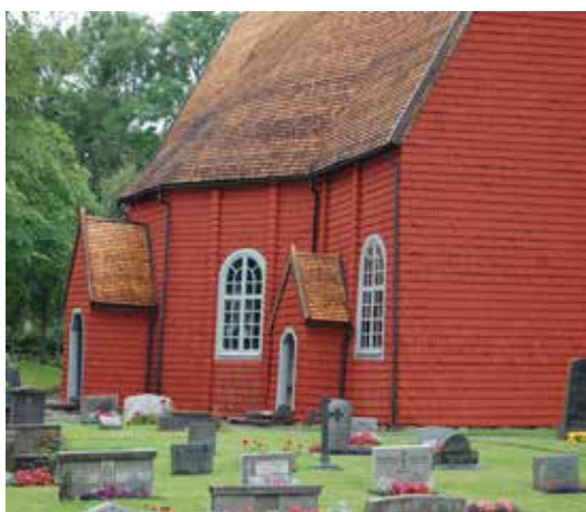
Kyrkan har stuprör och hängrännor av svartmålad plåt. Stuprören bör vara från 1927. De båda vapenhusen åt söder erhöll takavvattnings först 1987. Foto Anette Lindgren JLM 2009.
