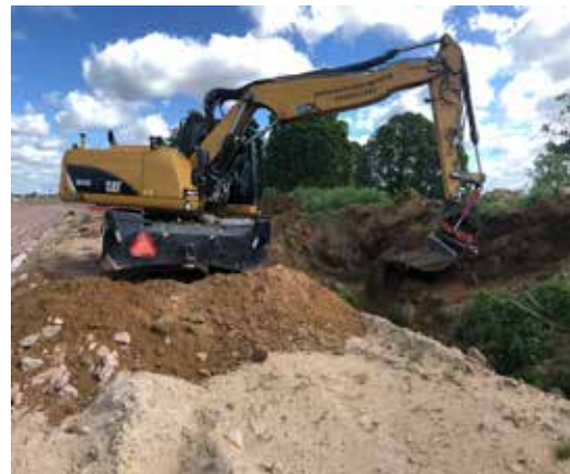
Figur 5. Extra sökschaktning efter syllstenar. Dessa var dock borttagna.
