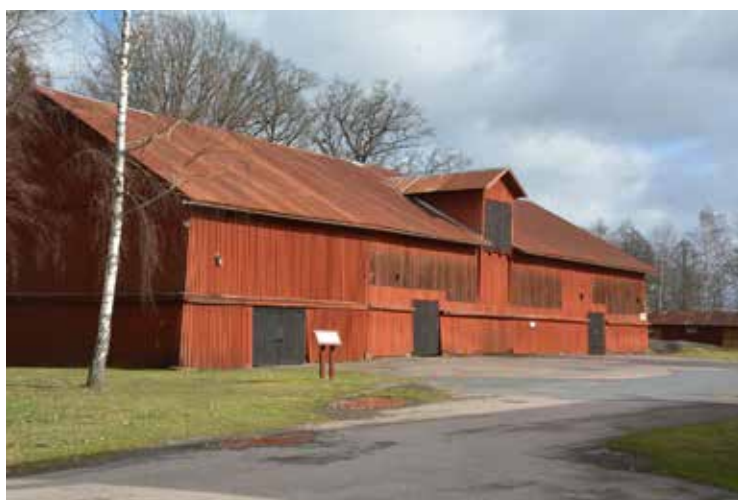
Kolladan före åtgärd.
