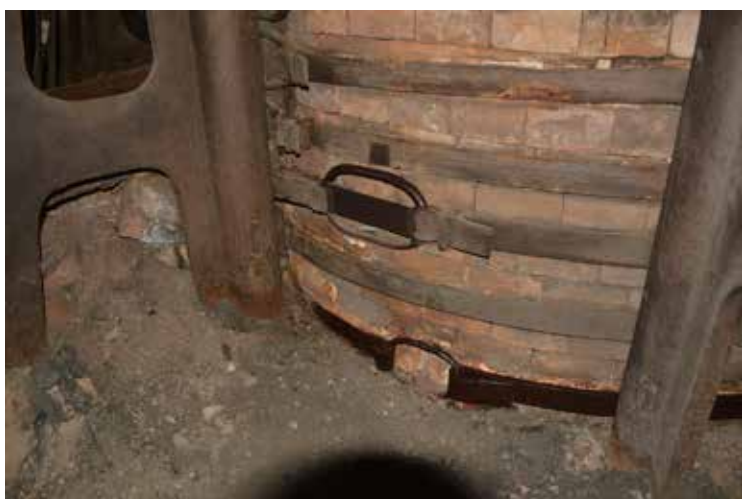
Lagat och målat dragjärn ner mot mark, samt ringen i det tredje bandet.
