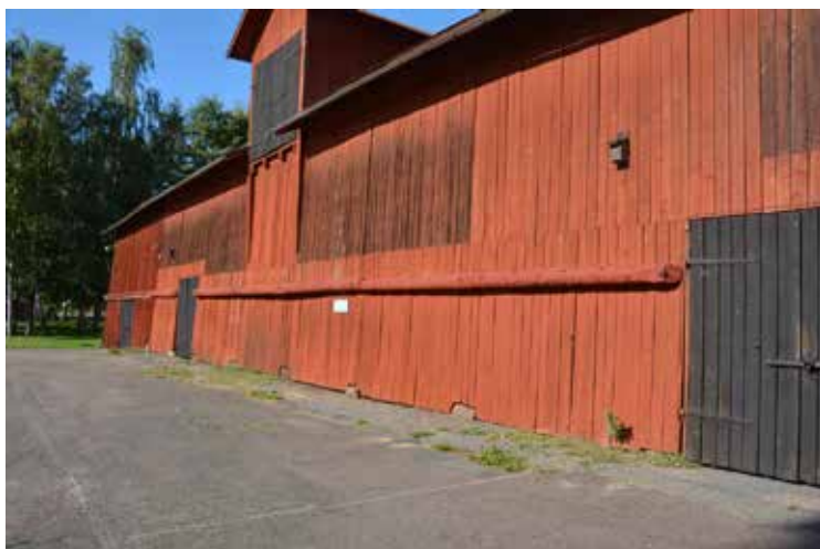
Översikt över bytta balkar.
