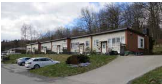
Tidstypiskt radhus som uppfördes under 1960-talet vid Svedvägen (Sibbatorp 1:28).
