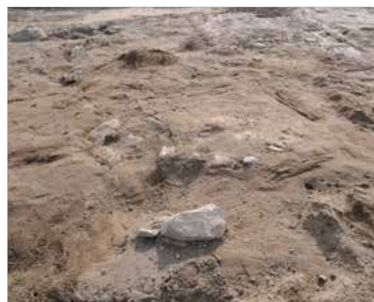
Figur 24. Det norra fundamentet i hus 9005. foto från norr.
