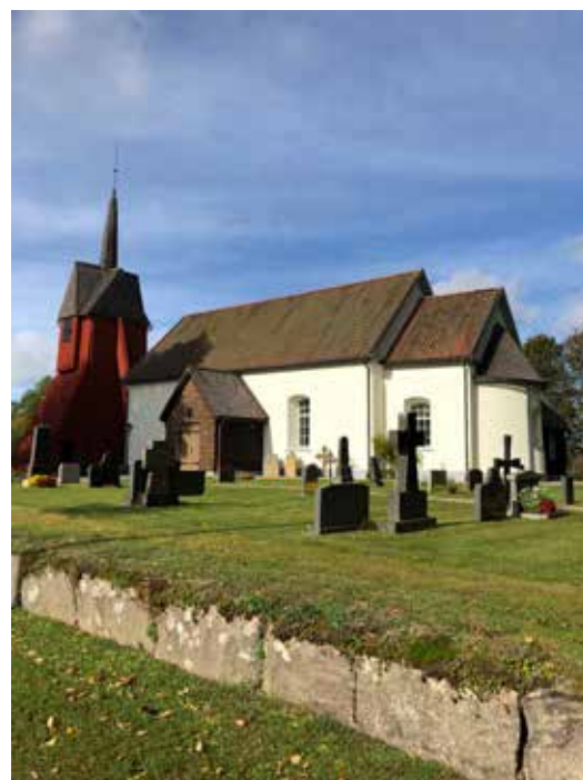
Den gamla kyrkogården är upphöjd och omges av en stödmur av kilade stenblock från 1862.
