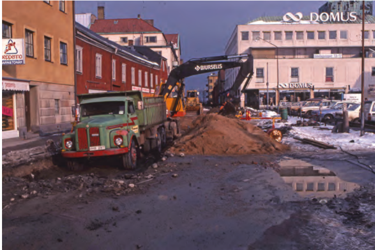
FIGUR 16. Schaktningar längs med Lantmätargränd med det nya Domushuset i bakgrunden, SR 34. Fotat från söder.
