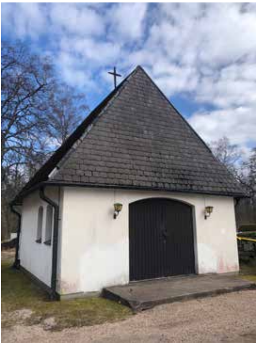
Bårhuset från 1957 ligger i anslutning till den norra ingången.
