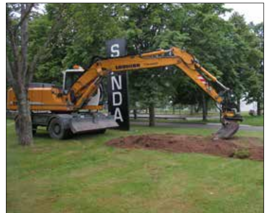
Figur 3. Schaktning i förundersökningsområdets nordvästligaste del. I bakgrunden skymtar parkeringsplatsen och en gång- och cykelväg som inte heller blev aktuell för förundersökningen sommaren 2021.
