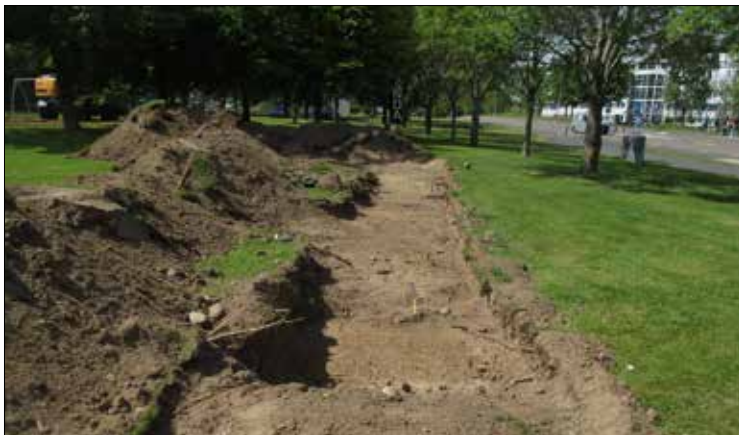
Figur 5. Exempel på schakt i den norra delen av förundersökningsområdet närmast Birkagatan där undergrunden var sandigare och grusigare än i södra delen. I förgrunden ses mörkfärgningen A7 markerad med gul pinne och i bakgrunden de båda härdbottnarna A5 och A6.
