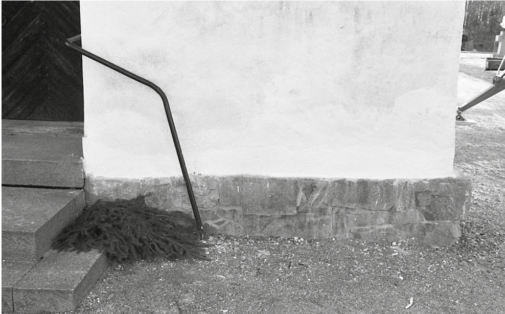
Tornets västra fasad, den nya avfärgningen är något ljusare än omgivande ytor.
