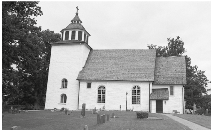
Kyrkan från söder före åtgärd.
