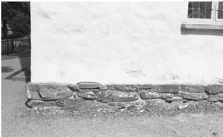
Tornets sydfasad före åtgärd.
