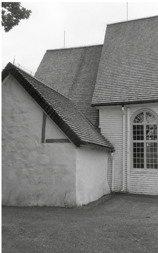
Sakristian före åtgärd, en spricka noterades i putsen i det nordvästra hörnet, i övrigt var putsen i gott skick.
