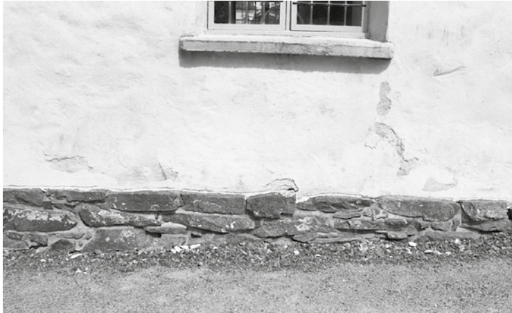
Tornets sydfasad före åtgärd.
