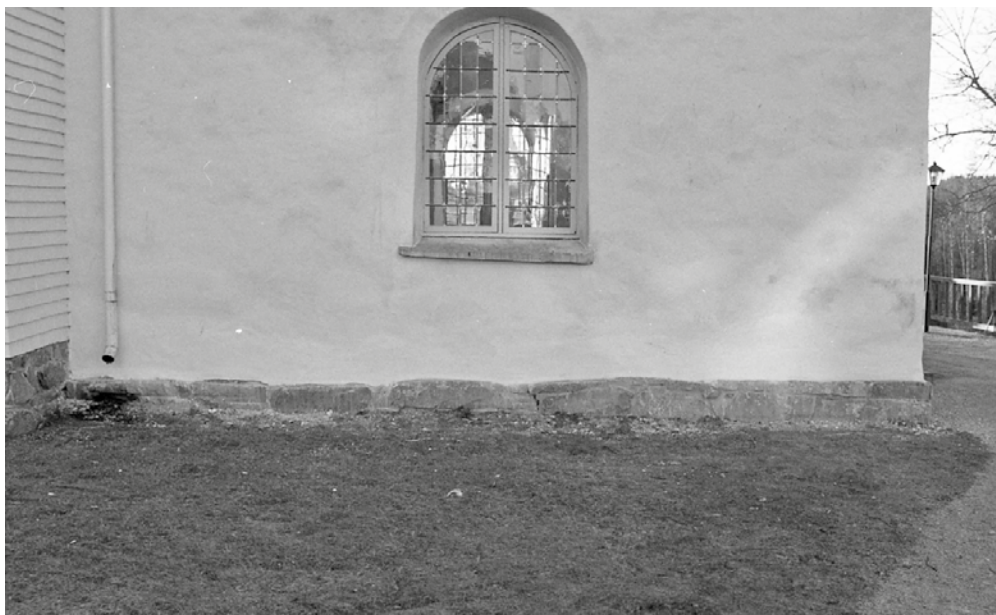
Tornets norra fasad.
