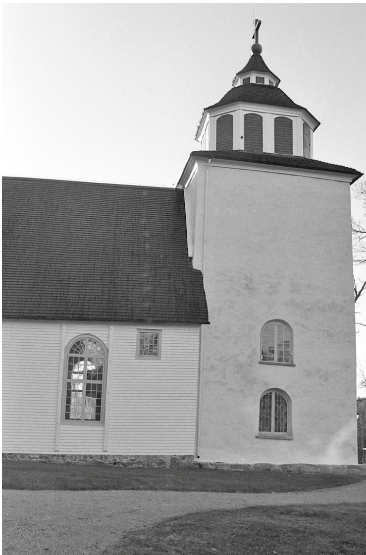
Tornets norra fasad
