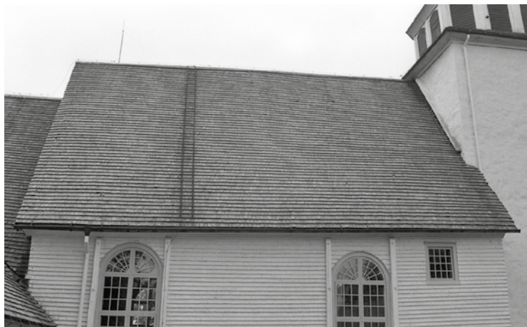
Sakristian före åtgärd, en spricka noterades i putsen i det nordvästra hörnet, i övrigt var putsen i gott skick.
