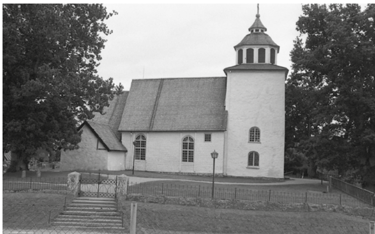
Stenberga kyrka före åtgärd.
