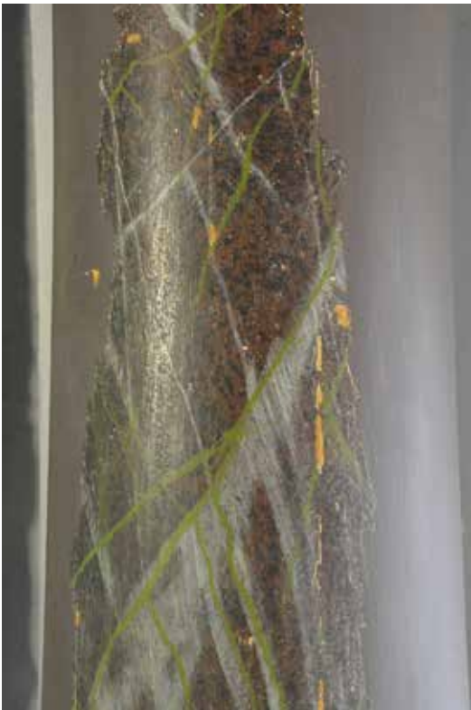
Underliggande marmorering på kolonner.
