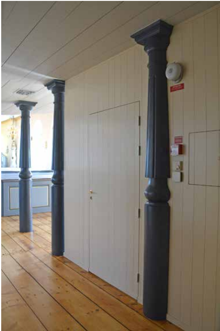
Den södra delen av läktarunderbyggnaden med dörren in till vaktmästarutrymmet. Dörren är utformad som panelen i övrigt och satt utan foder.
