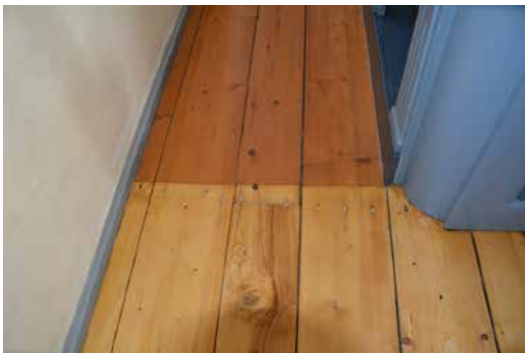
Den slipade och behandlade golvytan i sidogången och under borttagen bänkrad.
