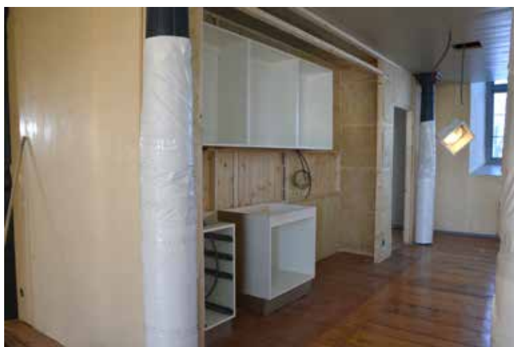
Pentryt under uppförande.
