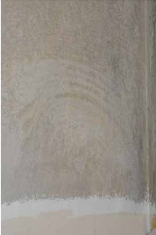
Bakom den rivna skåpsinredningen i vaktmästarutrymmet fanns rester av väggarnas tidigare målningsbehandling.
