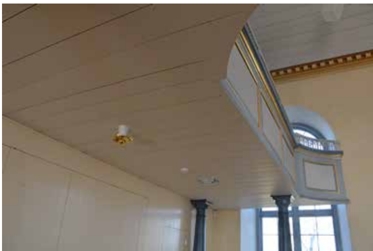
Taket under läktaren målades som kyrkans tak i en ljusgrå ton. Det sattes också ny kompletterande belysning under läktaren.
