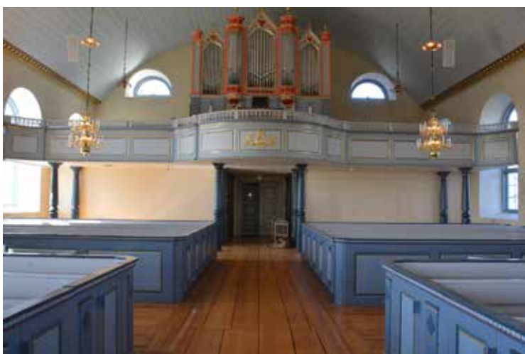
Översikt över den nya läktarunderbyggnaden.
