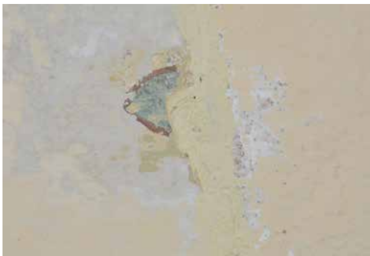
Rester av den tidigare dekormålningen framträdde i samband med rengöringen av väggen.
