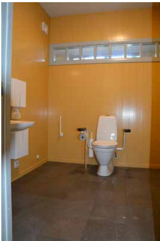
Den tillgänglighetsanpassade toaletten.
