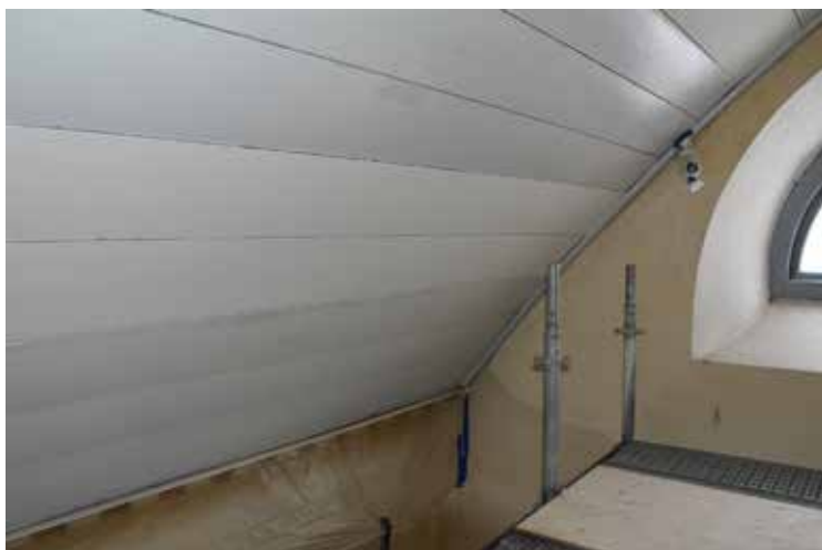
Pågående målning av taket och rengöring av de putsade väggarna.
