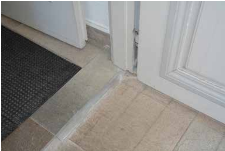
Tröskelstenen mellan vapenhuset och luftslussen fasades av för att öka tillgängligheten.
