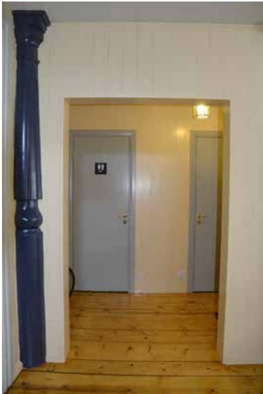
Kaprummet och toaletterna.
