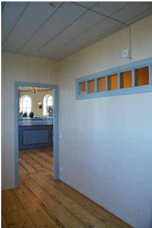
Barnrummet i den norra delen av läktarunderbyggnaden med fönstret som ger indirekt dagsljus på toaletten.
