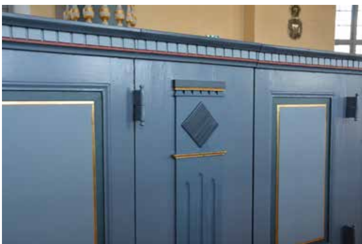
Bänkinredning efter bättringsmålning.
