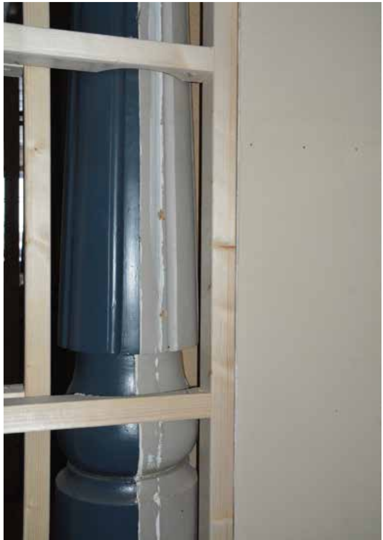
Bakom den rivna skåpsinredningen i vaktmästarutrymmet fanns rester av väggarnas tidigare målningsbehandling.
