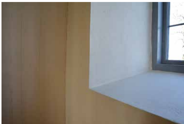
Fönsternischerna målades om.
