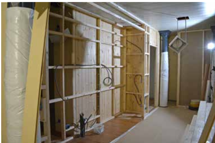
Den nya läktarunderbyggnaden under uppförande i regelverk och platsen för det kommande pentryt.
