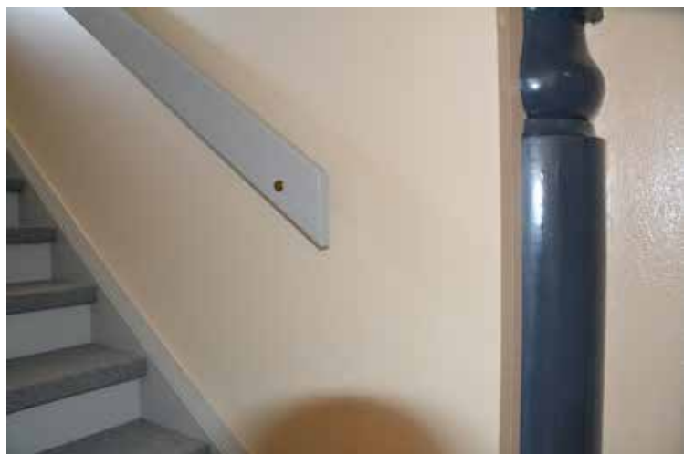
Trappan upp till läktaren i den södra delen av läktarunderbyggnaden.
