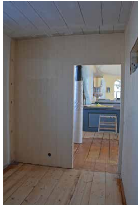
Den norra delen av läktarunderbyggnaden, pågående målning och slipning av golvet.
