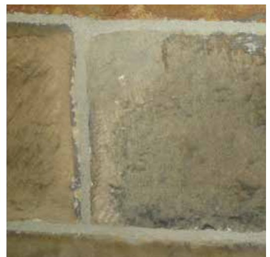
Ovan: Exempel på lagad sten med infärgat bruk. Till vänster: Trägesimsen efter avslutade arbeten.
