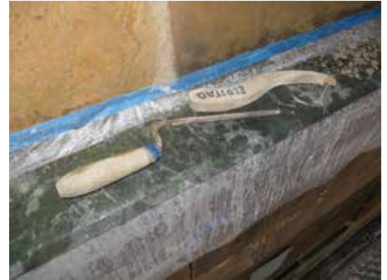
Ovan: Ett par av de verktyg som användes vid fogningen.
