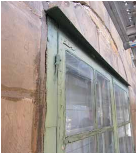
Detalj av fönster med plåtinklädd karm samt fogning inför arbetena.
