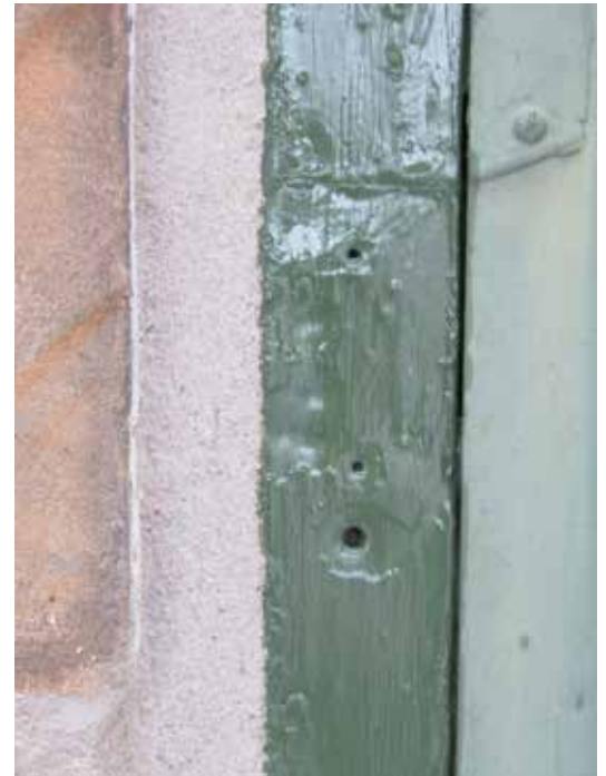
Spår i form av hål mm tyder på att det funnits markiser på ett par fönster.
