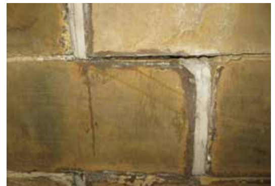
Här pågår omfogningen genom att bruket nästan har fyllt fogen. Därefter läggs de yttersta fogbruket i fogen. Efter att det torkat en stund drar muraren sedan med en träpinne för att få det önskvärda utseendet.
