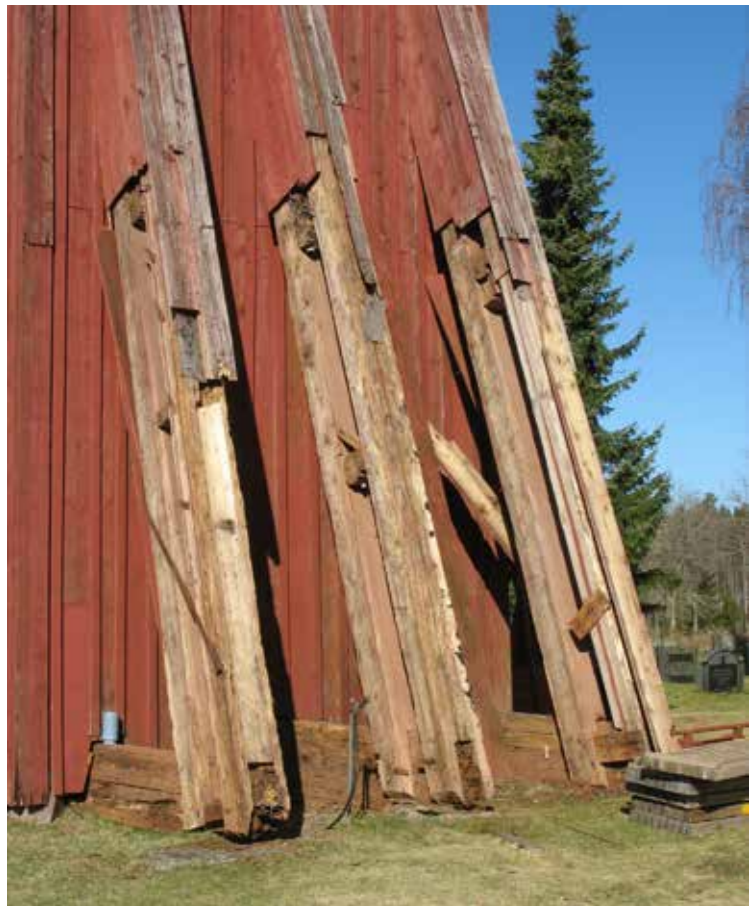
Mars 2010 inför byggstarten av restaureringen av skadad stödben, syll och panel. Foto: Robin Gullbrandsson, JLM.
