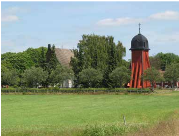
Klockstapeln i Hagshult efter restaureringen 2010. Foto: Robin Guillbrandsson, JLM.
