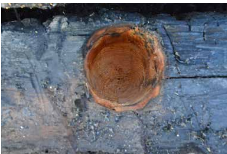
Ett av de ursprungliga dymlingshålen med spår efter navaren.
