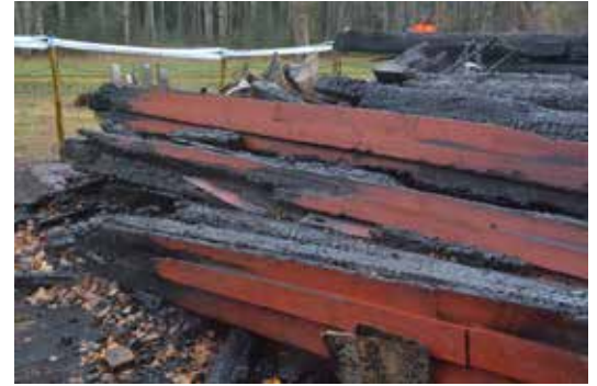
På stödbenens utsidor hade panelen inte brunnit upp utan satt kvar med rödfärgen i behåll.
