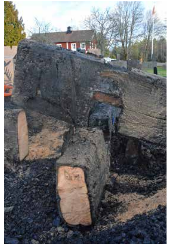
Demontering av en av syllens knutar.
