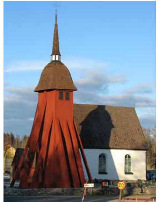
Mellby klockstapel och kyrka. Klockstapeln är länets äldsta klockstapel, dendrokronologiskt daterad till 1575. Stapel fick sitt nuvarande utseende 1673. Notera det stora antalet strävor.
