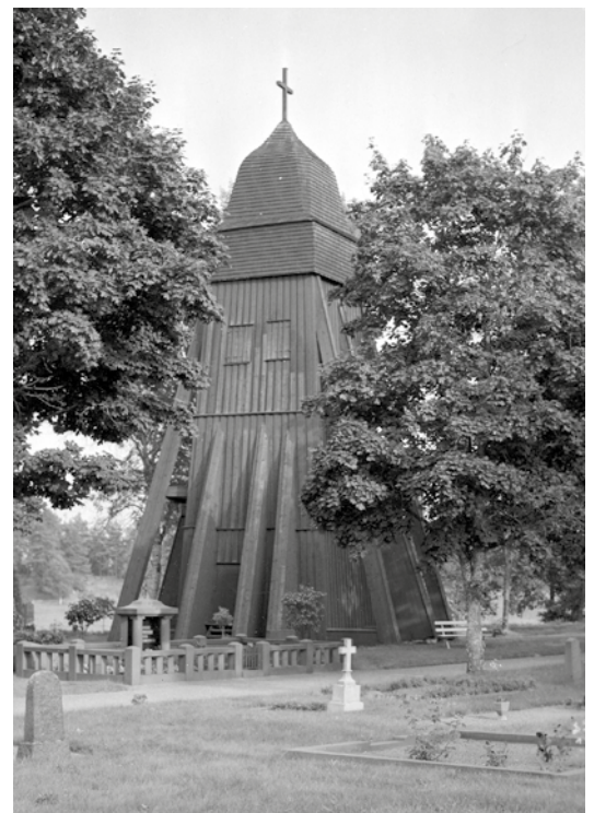
Klockstapeln vid Norra Sandsjö kyrka som är uppförd efter 1635 har precis som stapeln i Mellby tre strävor i vardera väderstreck.
