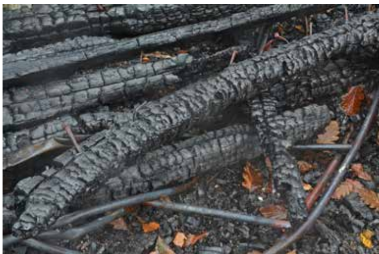
Bjälkarna till tornhuven. De var alltför brandskadade i ytan för att kunna avgöra om de var naturligt krok-vuxna eller om formen var uthuggen.
