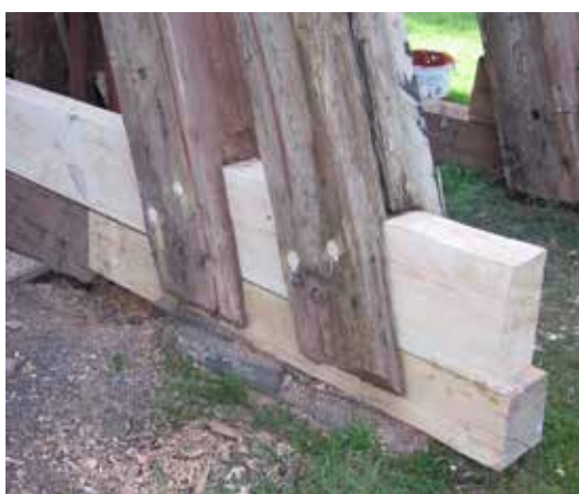
Bild av pågående lagning 2010. Vid de kompletterande dymlingarna kan man se vita rinningar som indikerar att man har nyttjat lim. Bild: Peter Kjöllér, BSV.
