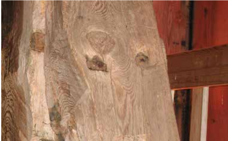
Detalj av de sammanfogande spikarna i stödbenen. Foto från 2010, JLM Robin Gullbrandsson.
