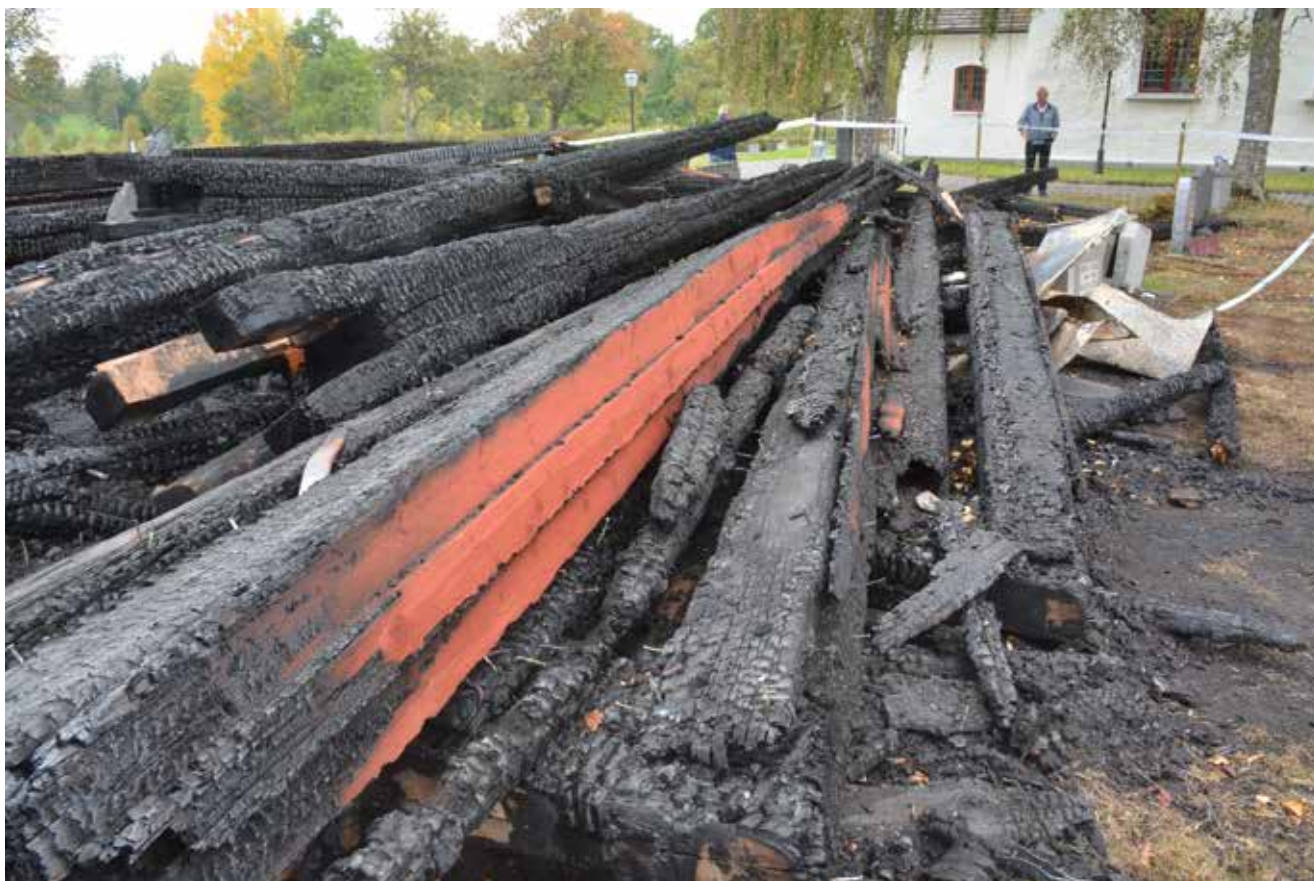
En bild tagen dagen efter branden, där man ser hur hjärtstockar och stödben har fallit åt norr.
