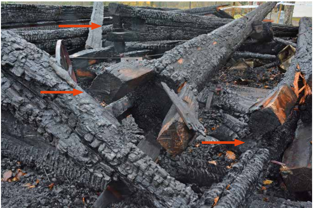
I bild kan man se de tre hjärtstockarna med deras gaffelknutar.
