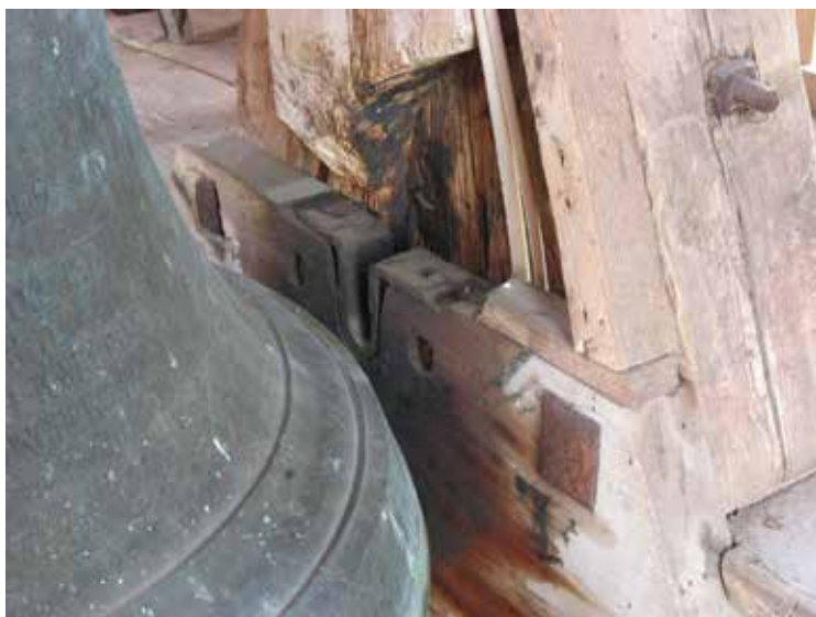
Klockorna hade hängts om i stalpeln och flyttats cirka en meter högre upp. Vid sidan om klockan syns läget för det tidigare klock-okets axel.
