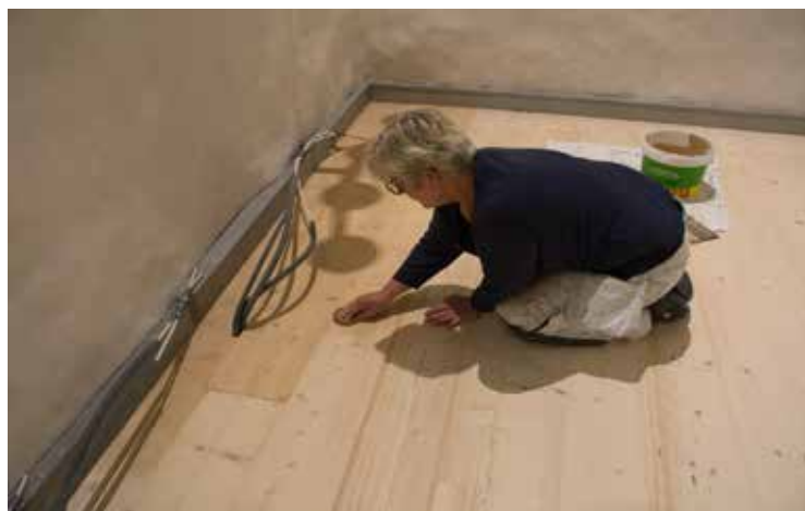
Anne Håkansson påför den pigmenterade oljan på det nyslipade golvet.
