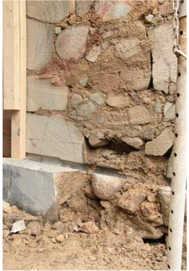
Den nedre delen av den västra murväggen.
