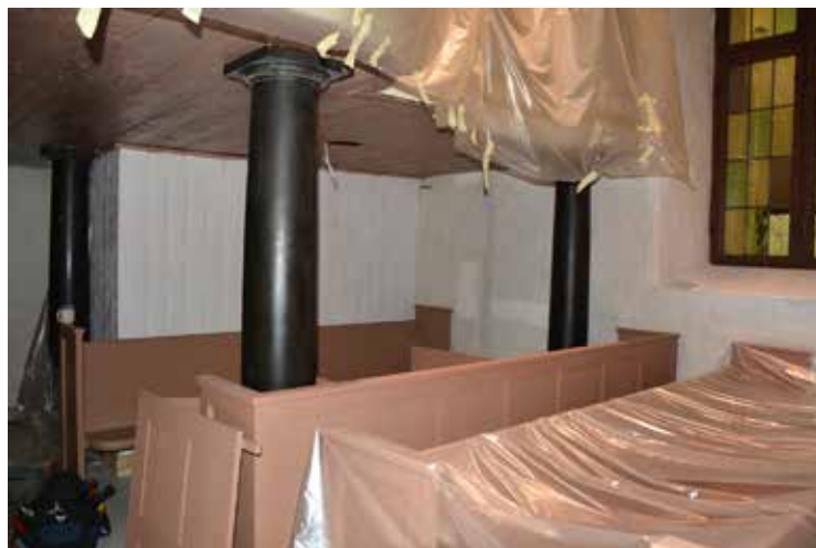
Pulten till mixerbordet monterad på plats.
