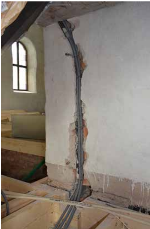
I de flesta fall gick det att dra om elen i de ursprungliga kanalerna utan att skada putsen, dock inte överallt, såsom här vid predikstolen.
