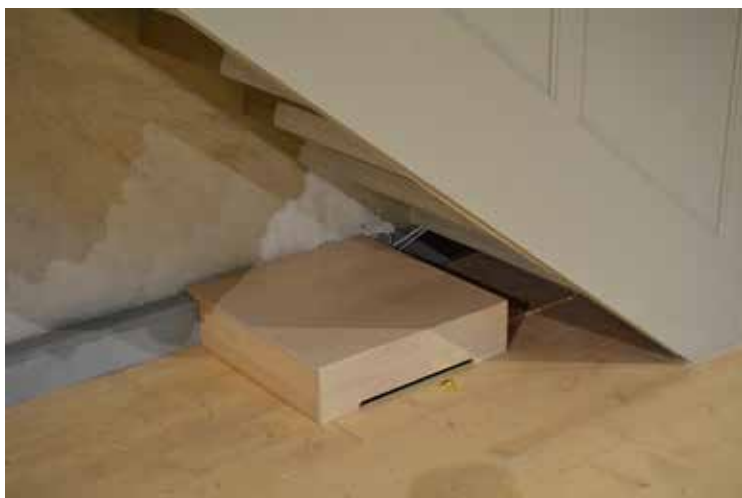
Kablarna till den så kallade danteboxen som länkar med ljudmixer och andra anslutningar för ljudanläggningen, skulle dras om för att vara mindre synliga.
