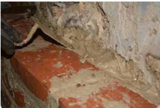
Detalj av pågående murning.
