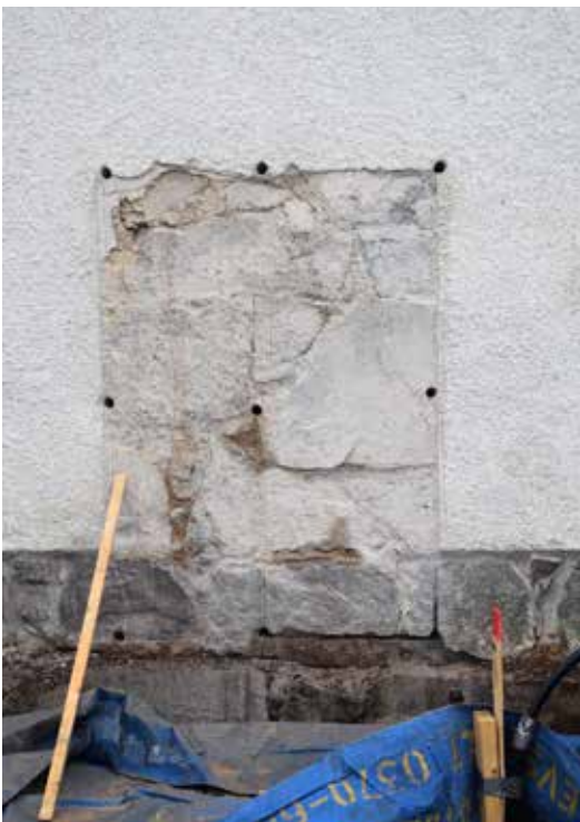
Muren inför håltagningen.
