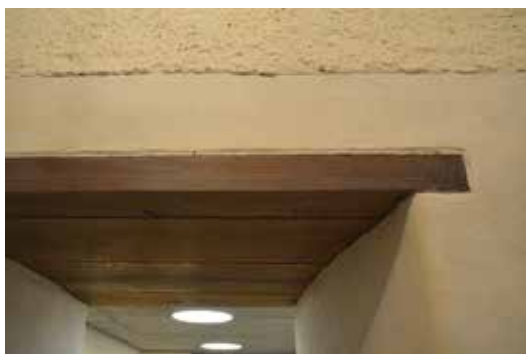
Avbärningen av muröppningen redovisas genom de synliga ekplanorna.
