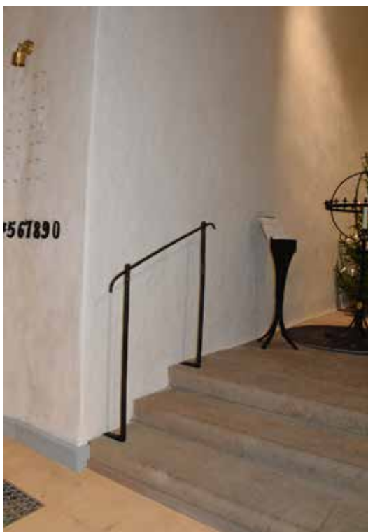
Ett smidesräcke sattes i trappan upp till koret som extra stöd men också för att skydda väggen. Räcket tillverkades av smeden Lars-Göran Larsson, Bodafors.
