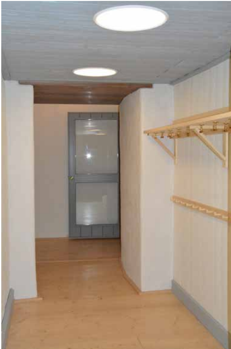
I gången in till tillbyggnaden kompletterades belysningen med nya plafonder. På väggen till höger syns den specialbyggda hyllan och knoppbrädan.
