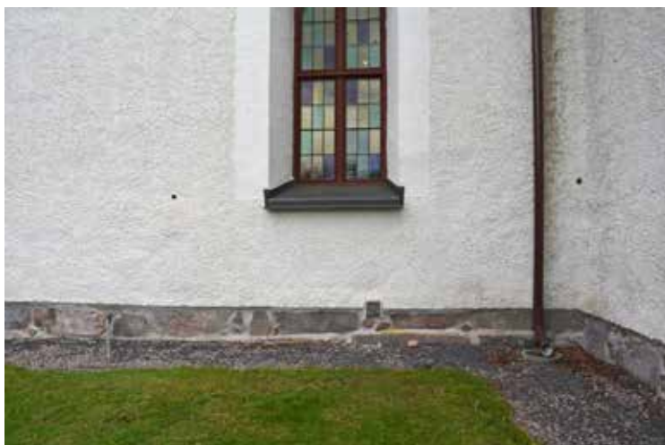
De tidigare ventilerna i grunden murades igen. En öppning behölls i den södra fasaden för ventilation till centraldammsugaren.
