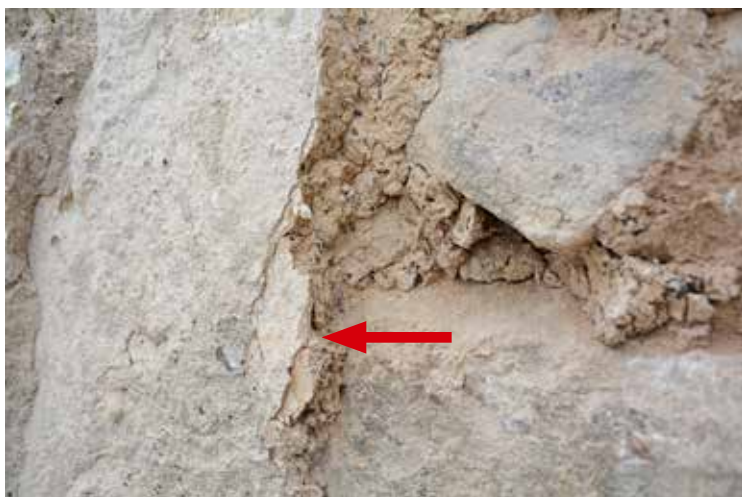
Detaljbild på den avfärgade ytan vid den östra sidan. Man kan se flera lager av kalkavfärgning under den sentida slamningen. Det feta bruket är poröst och med varierande kornstorlek.
