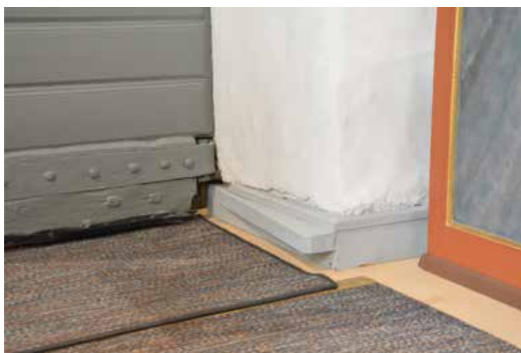
För att slippa slagskador i putsen specialtillverkades en dörrstopp av trä som målades in mot sockeln.
