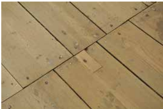
En smärre skada i golvet i läktarrummet lagades.
