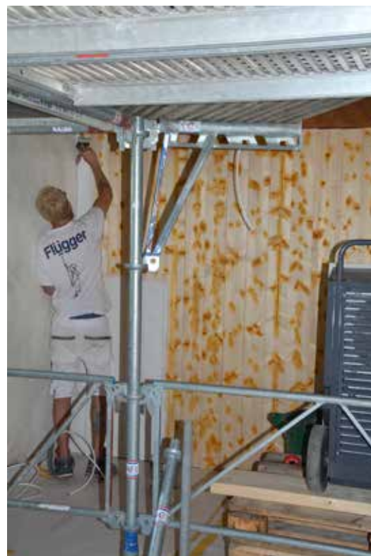
Schellackering av kvistar i den nya mellanväggen, med Daniel Håkansson vid penseln.
