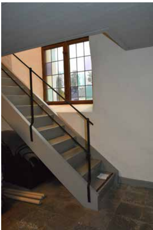
Trappan till läktaren målades en grå kulör. Vapenhusets tak behandlades på samma sätt som kyrkorummets tak.
