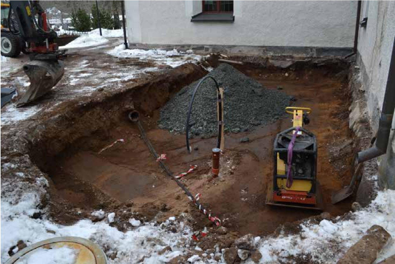
Pågående grundläggning för den kommande tillbyggnaden.
