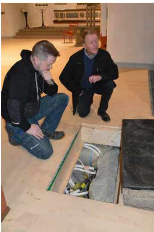
Thomas Hjert, Polo Kylteknik och besiktningsman Bernt Sjöland vid en av inspektionsluckorna.
