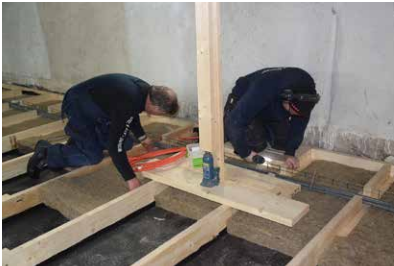
Ovan trossbotten lades en papp och sedan isoleringen i form av linnmattor. Arnold Ljung och Mikael Fredriksson lägger isoleringen. I bilden ser man också stegen med elkabeldragningen och den tillfälliga avbärningen av läktaren.
