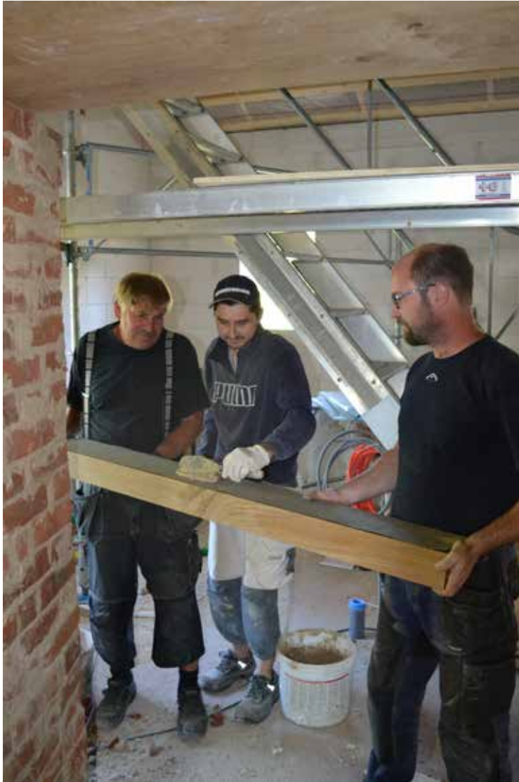
Ekplanken förbereds för att skjutas in ovanpå tegelmurarna i muröppningen. Från vänster Arnold Ljung, Stefan Kraev och Mikael Fransson.
