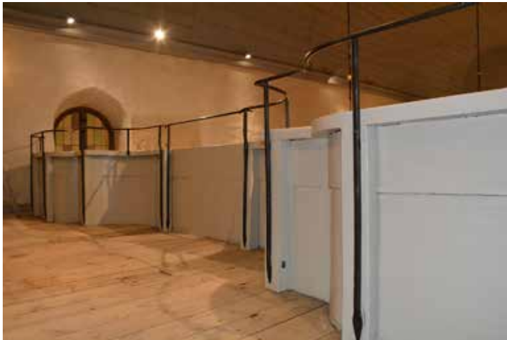
Golvet på läktaren togs fram och såpskurades. För att uppnå godkänd höjd på läktarbröstet kompletterades barriären med ett smidesräcke. Räcket tillverkades av smeden Lars-Göran Larsson i Bodafors.
