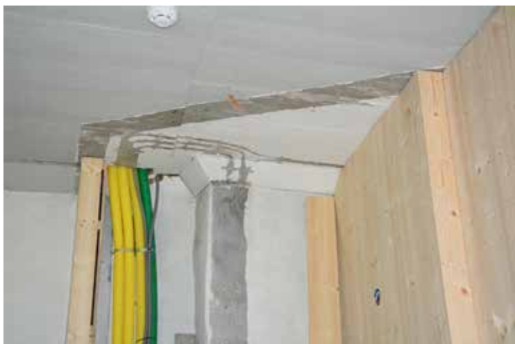
Väggen mellan rummet oftanför trappan och läktaren kläddes med panel och flyttades något i partiet närmast muren, färgspåren i taket markerar väggens tidigare läge.
