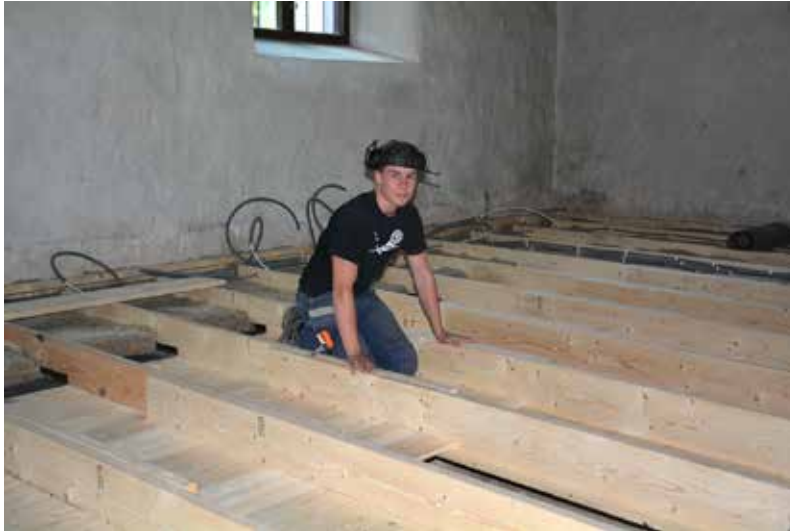
Det nya golvet byggdes upp med reglar. Här lägger Douglas Kursten trossbotten.
