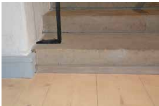
Skarven mellan kortrappan och det nylagda golvet täcktes med en enkel sockellist som målades in mot trappan.
