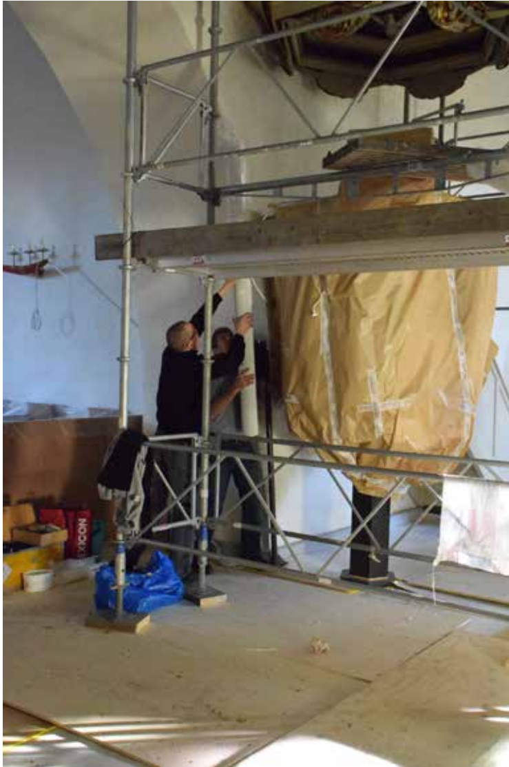
Provhängning av högtalarna för att se vilken placering som var minst iögonfallande. Här vid predikstolen.
