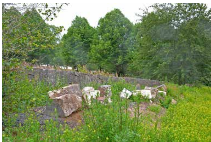
Stenarna från murgenombrottet ligger på en för ändamålet utlagd grusbädd strax väster om kyrkogårdsmuren i nordväst.
