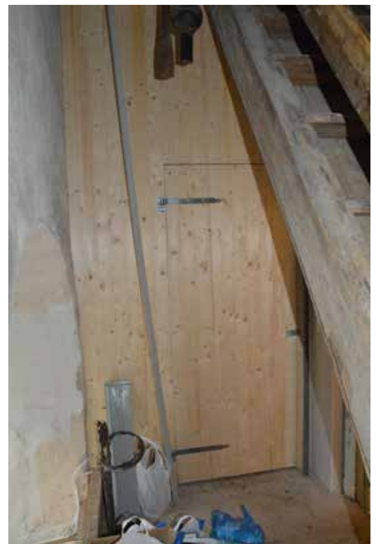
Ett förråd platsbyggdes i trapphuset i tornet.
