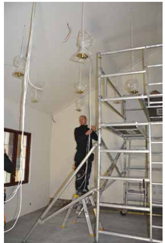
Provhängning av pendelarmaturerna i tillbyggnaden..
