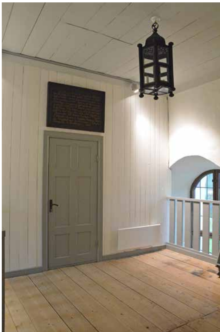
Läktarrummet. Väggen in mot orgelläktaren kläddes med panel och en ny dörr tillverkades med dörren mot vinden som förebild. Det täckta träräcket byttes till ett med spjälor lika räcket vid fönstret i norr.
