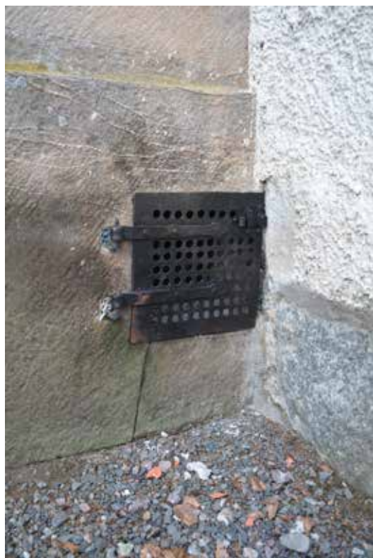
Det nytillverkade gallret varigenom till- och frånluft för avfuktningssystemet går.
