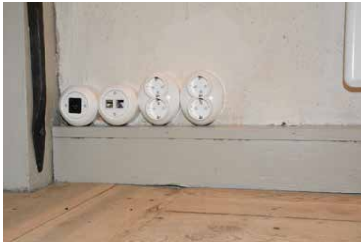
Nya utanpåliggande eluttag av modell Renova, samt för nätverk.
