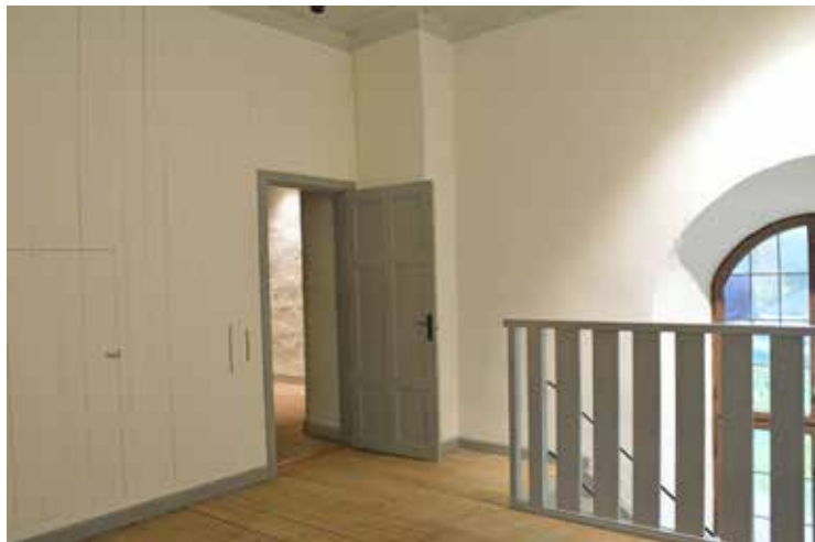
Läktarrummet. Väggen in mot orgelläktaren kläddes med panel och en ny dörr tillverkades med dörren mot vinden som förebild. Det täckta träräcket byttes till ett med spjälor lika räcket vid fönstret i norr.
