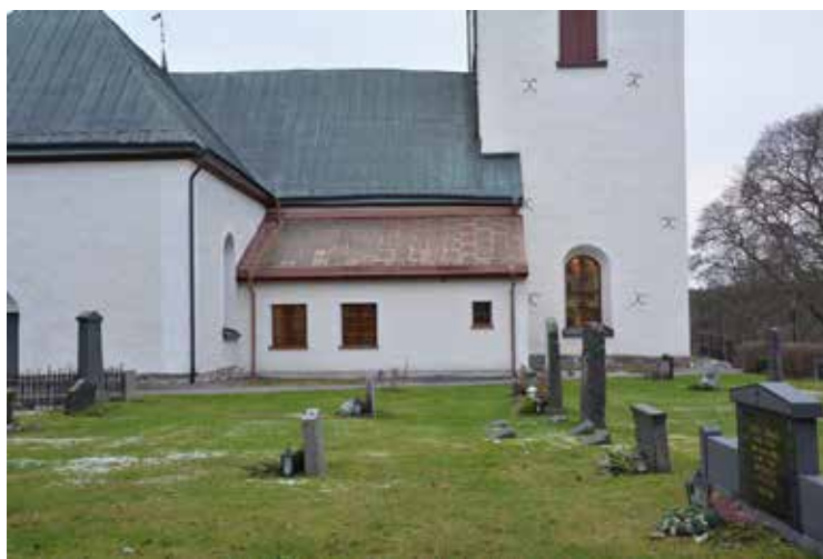
Tillbyggnaden från norr.
