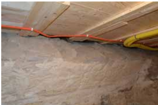
Samtliga installationer fästes i den nya golvkonstruktionen.
