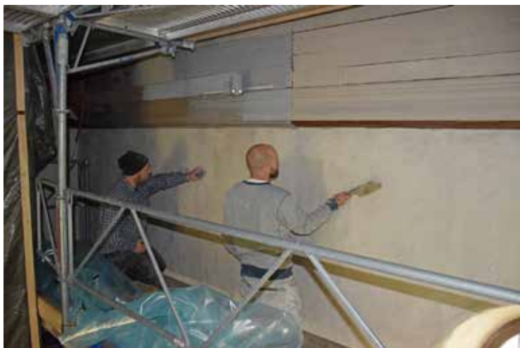
Väggarna i långhuset rengjordes med Wishabsvamp, Pierre Håkansson rengör med svampen och Nicklas Håkansson borstar rent.
