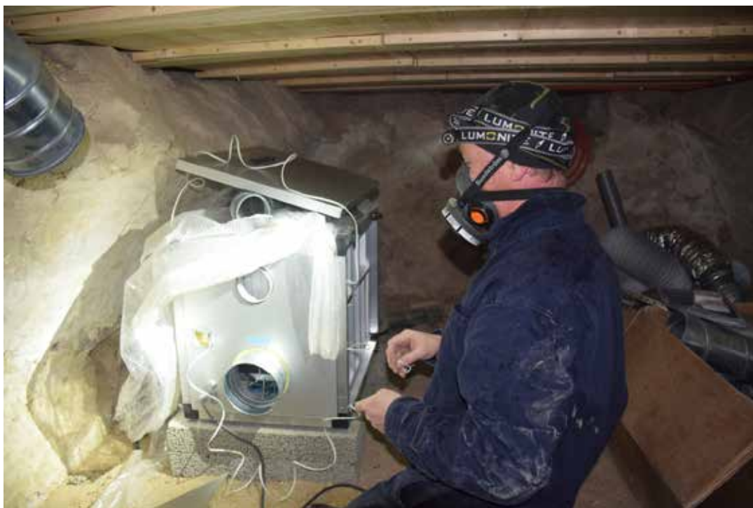
Tomas Pettersson, Ljungby Fuktkontroll monterar avfuktningssystemet.
