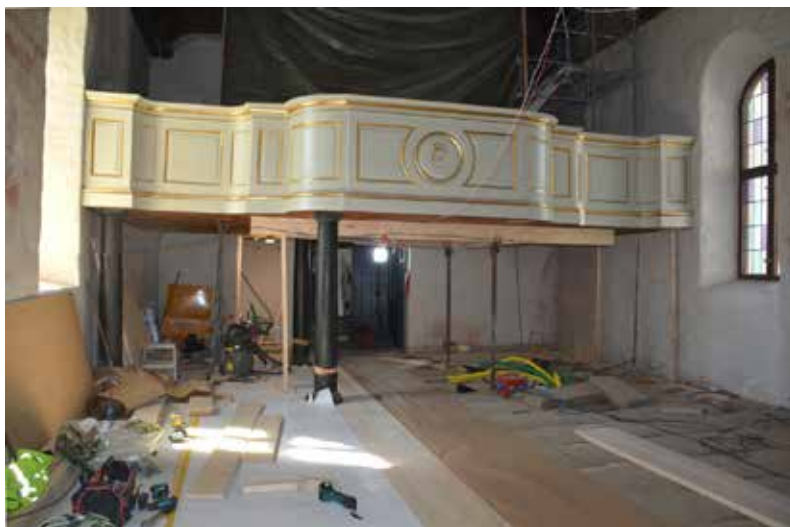
För att skydda golvet så täcktes det nylagda golvet så fort det var på plats. Här är också en av kolonnerna som bär läktaren återmonterad.
