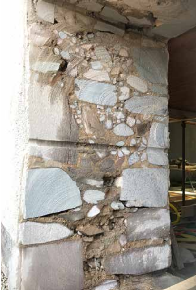
Den östra sidan av murväggen.
