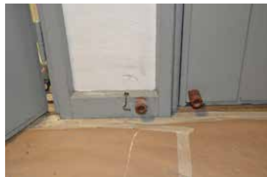
Tidigare dörrstoppar byttes mot platsbyggda i trä.
