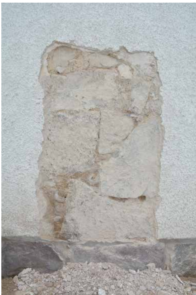
Översikt över den utvändiga undersökta ytan. I dess nedre del är bruket brunare än i muren högre upp på väggen.
