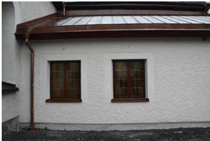
Tillbyggnaden exteriört med dess anslutning mot den norra korsarmen.
