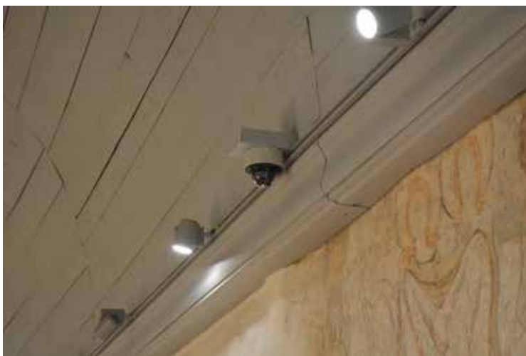
Den kompletterande belysningen i kyrkorummet består av spotlights placerade på en skena på taklisten. I bild syns även en kamera som hjälper kantorn att följa det som sker i kyrkorummet (kameran spelar inte in).
