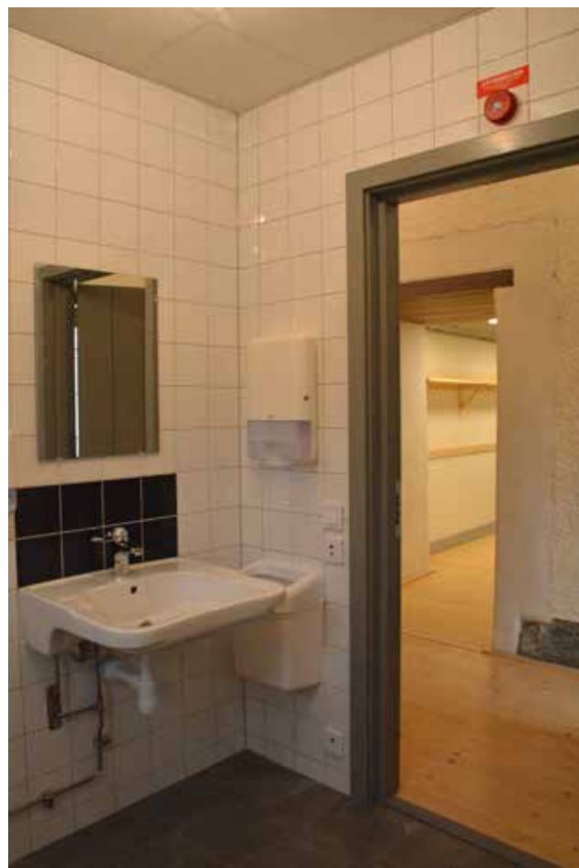
Som synmarkering är kakelplattor i kontrasterade färg satta vid toalett och handfat.
