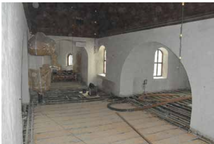
Kyrkorummet, golvet är uppbrutet och utsugning av kutterspårsfyllningen i trossbotten pågår.
