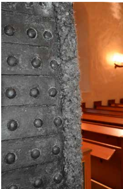
Fårskinn sattes som tätning vid portarna till sidogångarna.
