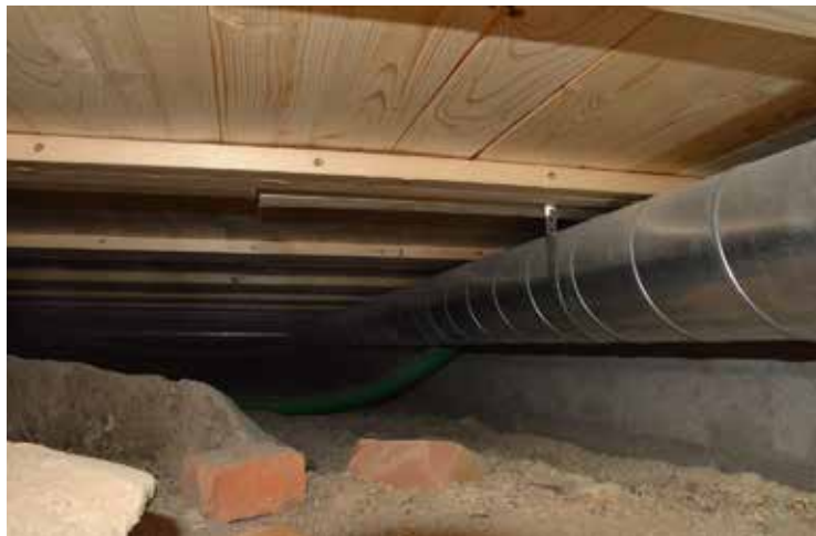
Samtliga installationer fästes i den nya golvkonstruktionen.
