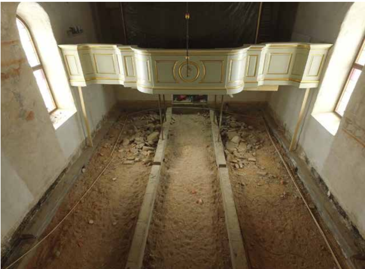
Bild från öster mot läktaren.
