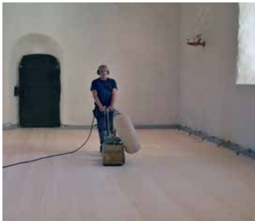
Efter att väggarna var klara och ställningen demonterad slipades golven.
