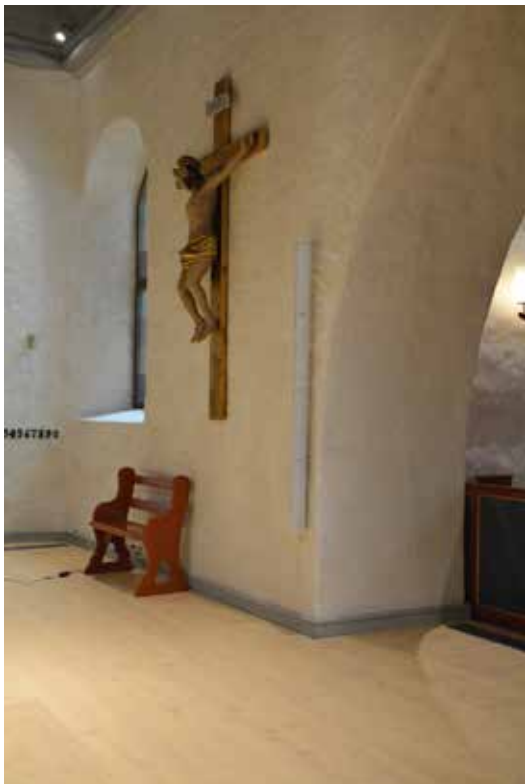
De nya högtalarna monterades på respektive sida av valvbågarna mot koret.
