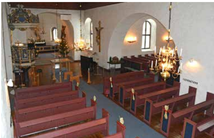
Byarums kyrka före åtgärd.
