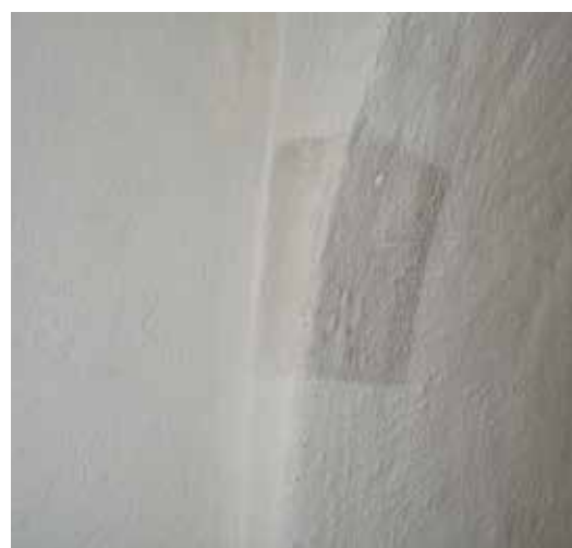
En referensyta i koret med en sparad icke rengjord yta.
