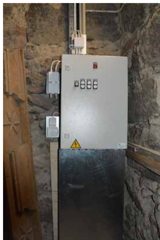
Ett kompletterande elskåp på vinden som i första hand tillgodoser lyftarna till ljuskronorna.
