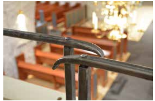
Räcket sektionerades för att kunna följa läktarbröstets svängda form, men också för att kunna tillverkas i smedjan.
