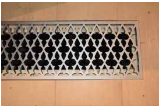
Ett av utluftsgallren med det specialtillverkade gallret.
