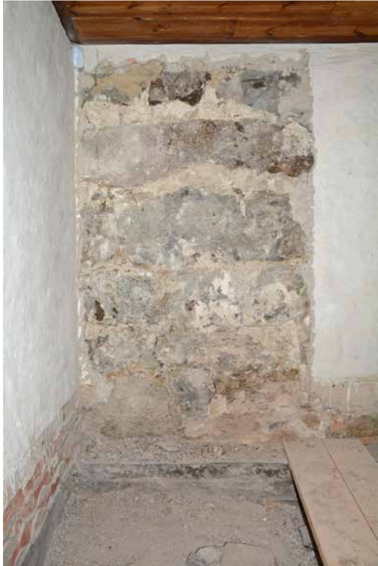
Översikt över den invändiga framtagna muren.
