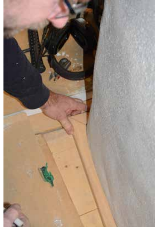
Inpassning av golvlisten i tillbyggnaden. Listen drogs efter muren för att kompensera murens ojämnhet.
