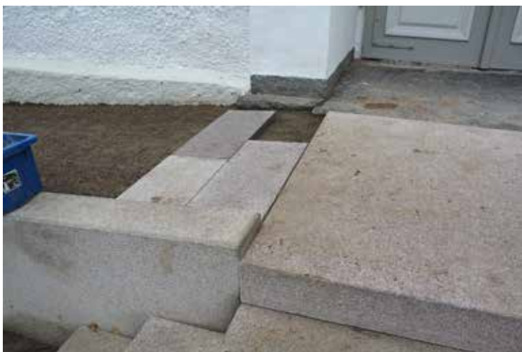
Den nya rampen lades genomgående med stenhällar och i fallande längder för att få en variation i hur skarvarna hamnade.
