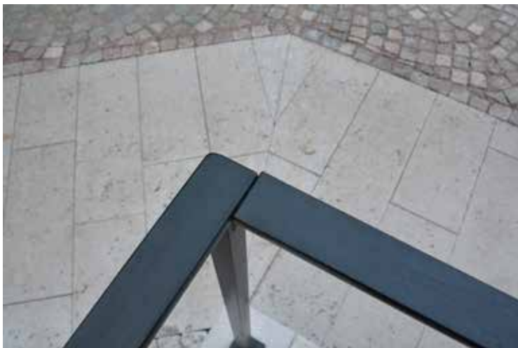
Detalj av räcket åt norr, det skulle justeras så att de båda överliggarna linjerar. Notera mötet mellan stenarna i gångstråkets vinkel i bakgrunden.
