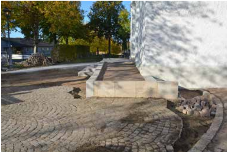
Utläggningen av den nya rampen från söder. Stenblocken i den södra sidan av rampen är återanvända från den gamla rampen.
