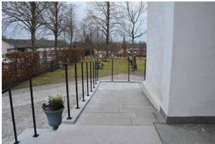
Rampen åt norr, sett från översta trappsteget.
