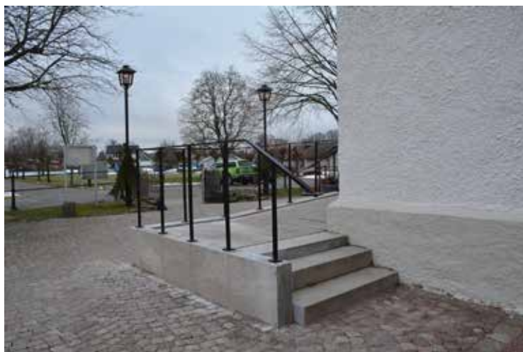
Rampen från söder med den avslutande trappan och de återanvända stenarna i rampens södra sida.
