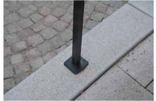
Detalj, täckbricka över stolpens infästning i stenen.
