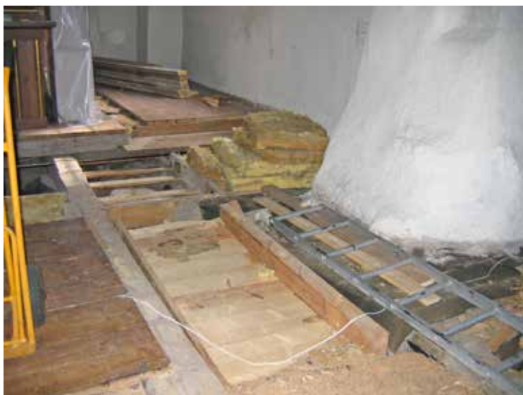
Golvet i korets södra del var mera nyligen omlagt och isolerat med mineralull.
