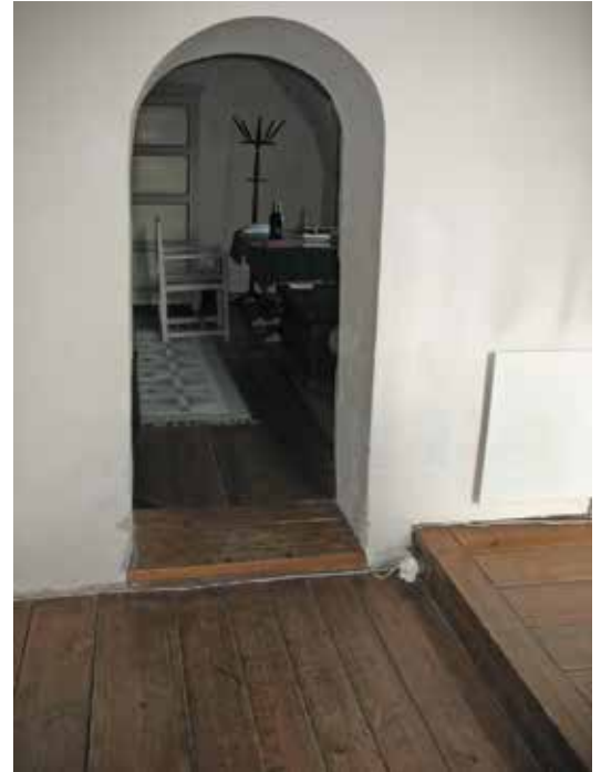
Korets norra vägg med dörröppningen in till sakristian. Till höger i bild syns en av de gamla radiatorerna, notera även de lösa ledningarna som ligger längs med golvet.
