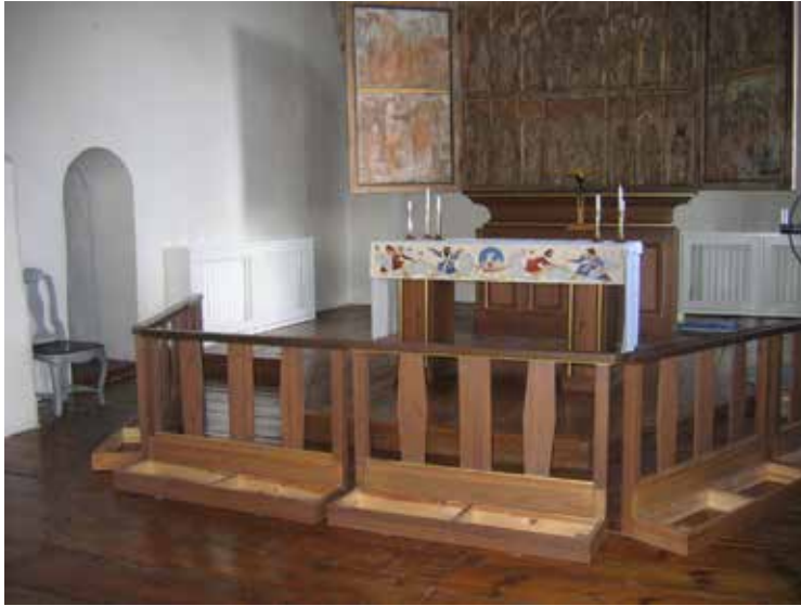
Koret, med en radiator vid norra väggen och en vid den östra. Altarringens knäfall var inte återmonterade vid besiktningen.
