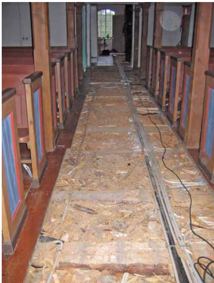
Det demonterade golvet i mittgången i den västra delen av kyrkan. De tidigare installationerna ligger i en ledningsgata till höger i bild samt med dragningar in till respektive bänkvärmare i det södra kvarteret.
