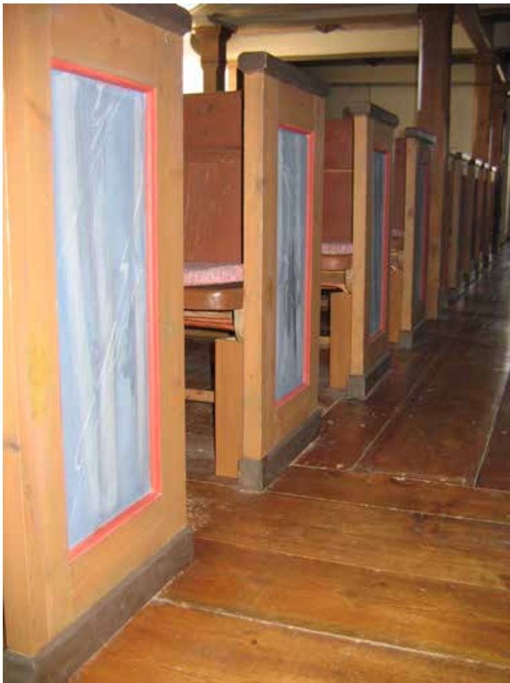
Bänkarna i sydvästra bänkkvarteret med de inmålade lådorna innanför bänkgaveln som döljer och skyddar de vertikala rördragningarna.
