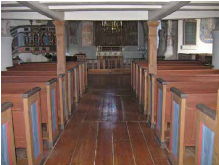
Den återlagda mittgången efter den avslutade installationen.
