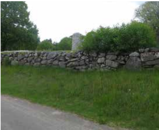
Den gamla kyrkogårdsmur av fältsten ligger kvar i sina södra och norra sträckningar.
