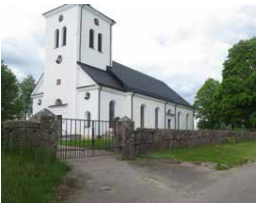
Muren som anlades omkring kyrkan 1889 är av råkilade kvaderblock i röd granit. Muren är enkelsidig och har tidigare varit försedd med häck på insidan.
