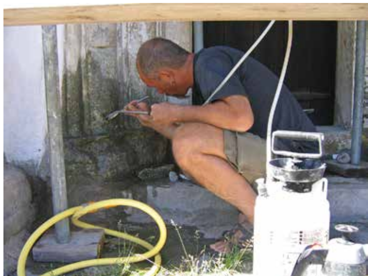
Pågående stenkonservering av sydportalen.
