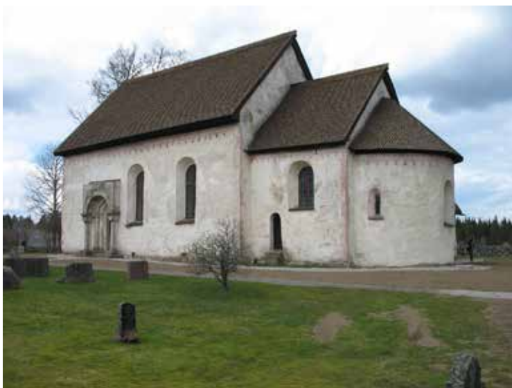
Kyrkan före åtgärd, från sydost. Våren 2008, dräneringsåtgärderna är utförda i anslutning till kyrkan.
