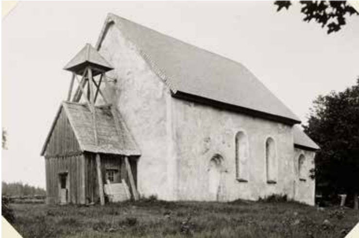
Kyrkan från sydväst före restaureringen, foto 1927 Mårten Sjöbeck, Lunds universitetsbibliotek.
