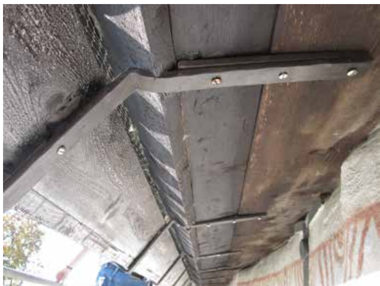
Den nyuppsatta hänggrännen vid södra korväggen med de smidda krokarna. (Foto från september 2011).
