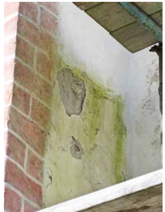
Skadorna var mest omfattande i vinkeln mellan långhusets södra gavel och korets södra vägg.
