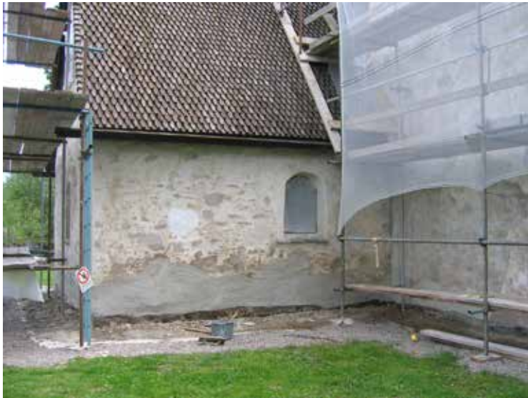
Utförda putslagningar på sakristian, maj 2009.
