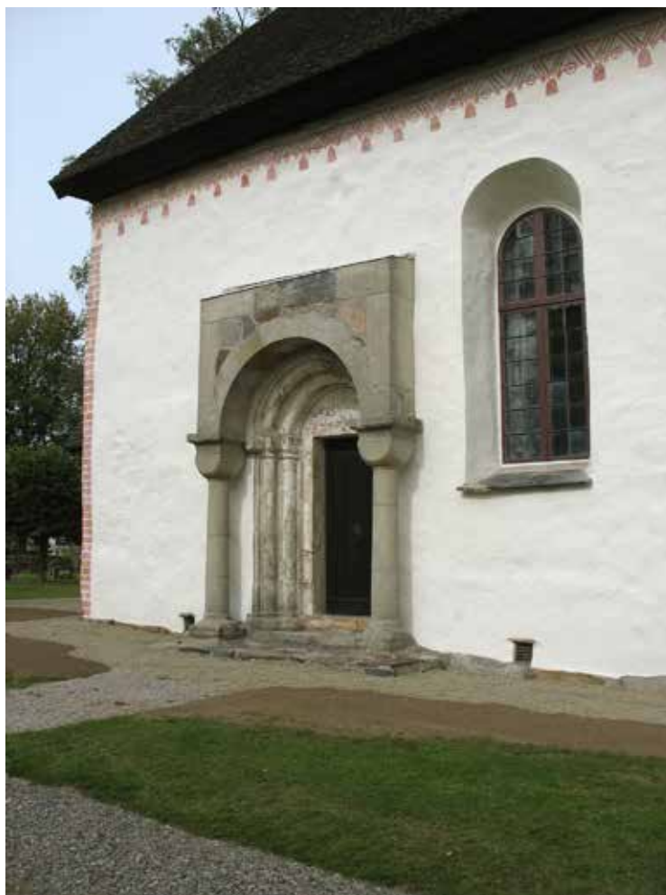
Den södra långsidan med den konserverade sandstensportalen.
