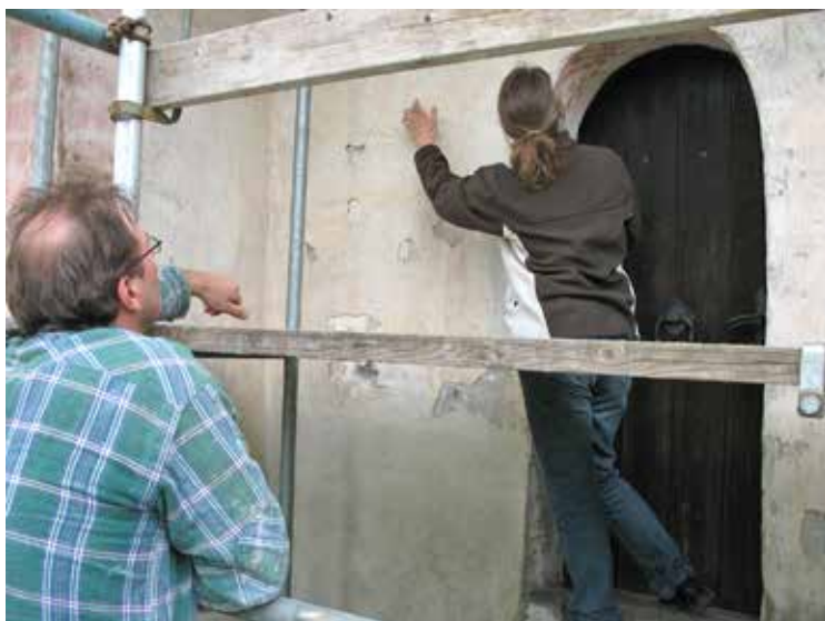
Gunnel Rosenquist och Staffan Bergström besiktigar korväggen inför kommande arbeten.
