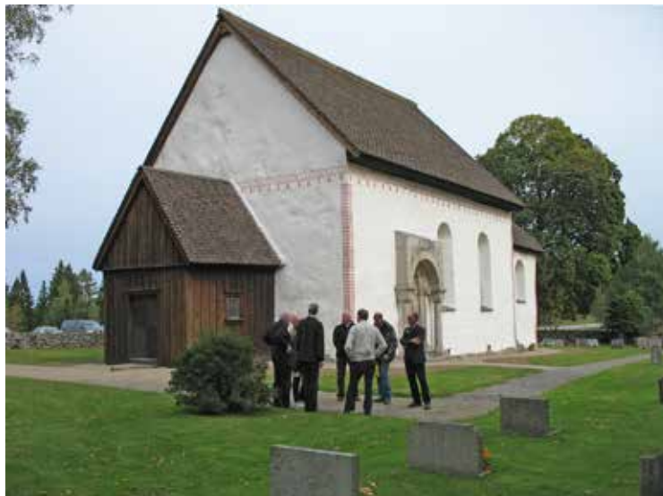
Kyrkan från sydväst, vid slutbesiktningen.
