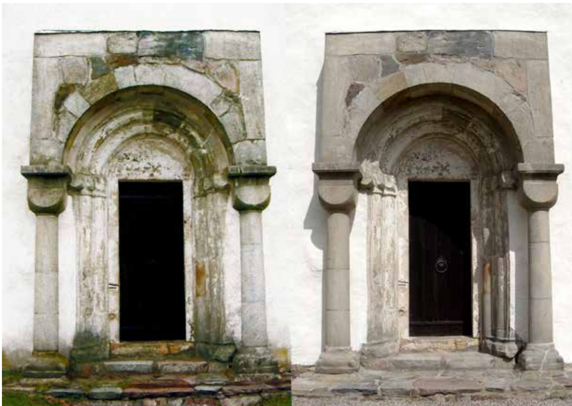
Portalen före och efter konservering
