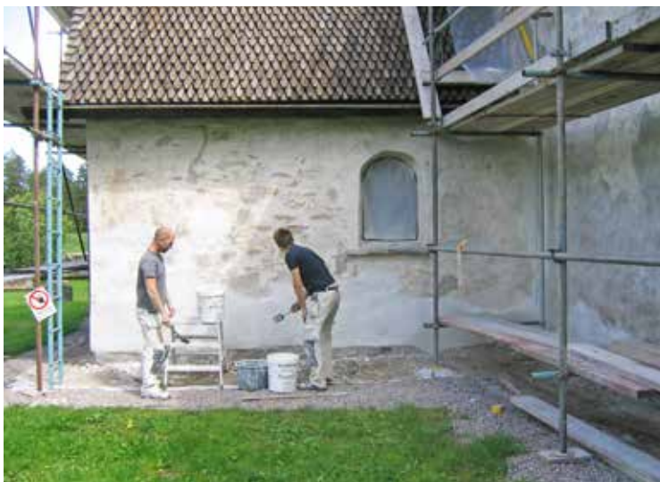
Inledande avfärgning av kyrkan, juni 2009.
