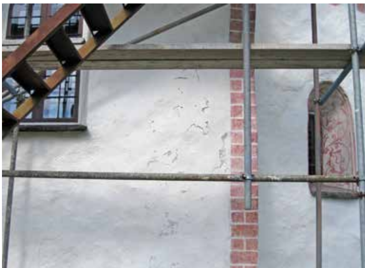
Skadorna var mest omfattande i vinkeln mellan långhusets södra gavel och korets södra vägg.
