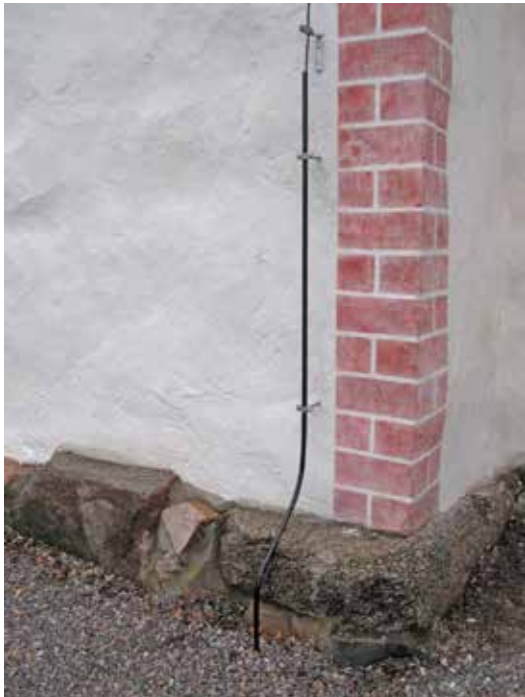
Skador lagade efter byte av åskledare.
