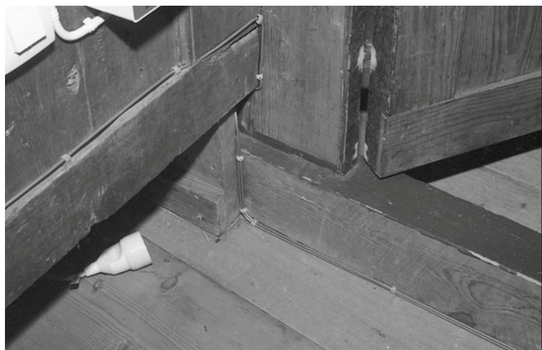
Kablarna drogs och klamrades mot bänkinredning och lister.
