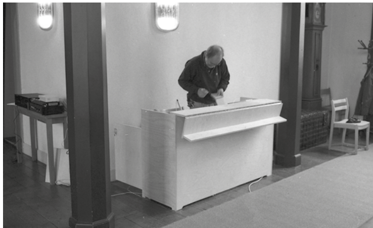
Pågående installation av den nya manöverpulten.
