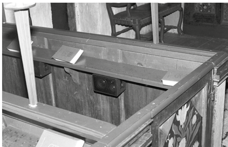
I de främre bänkarna i koret monterades små högtalare på bänkskärmens insida då det inte var framkomligt med hörselslingan i krypgrunden.
