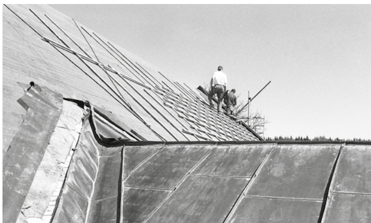
Pågående arbeten, ny takpapp är lagd och läkten är underläggning.
