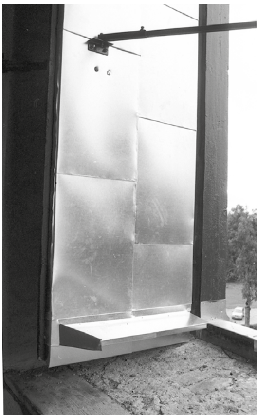
Ny plåtbeklädnad på luckorna. Då plåten var behandlad kunde de inte målas i anslutning till montering.
