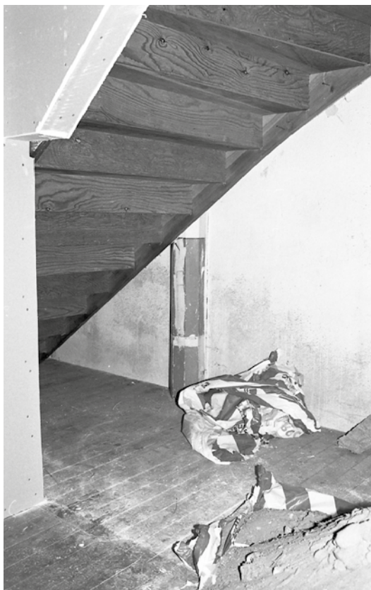
Det tidigare lilla förrådet under trappan är rivet.
