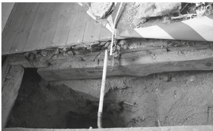
Håltagning under golvet genom mur för avlopp.
