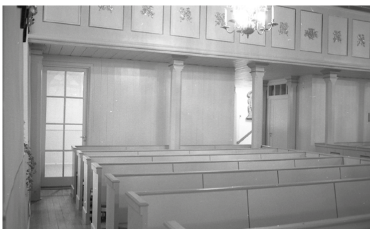
Läktarunderbyggnaden i sydväst.
