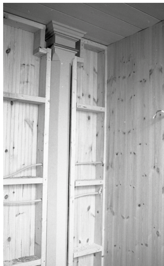
Läktarunderbyggnaden under uppförande. I bilden syns också dragningen för elektricitet i väggarna.
