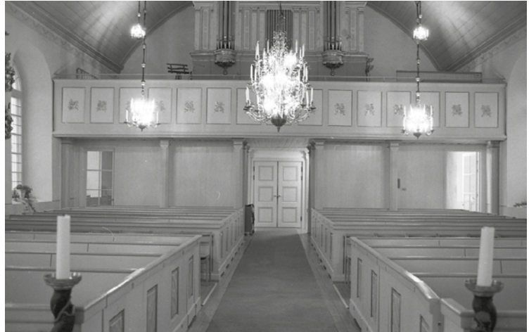
Läktarunderbyggnaden, översikt från koret.
