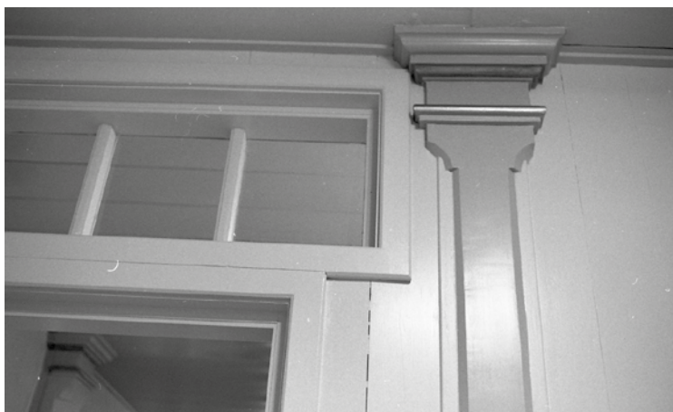
Detalj av anpassningen mot befintlig pelare.
