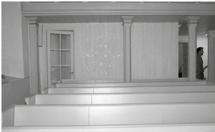
Läktarunderbyggnaden vid slutbesiktningen.
