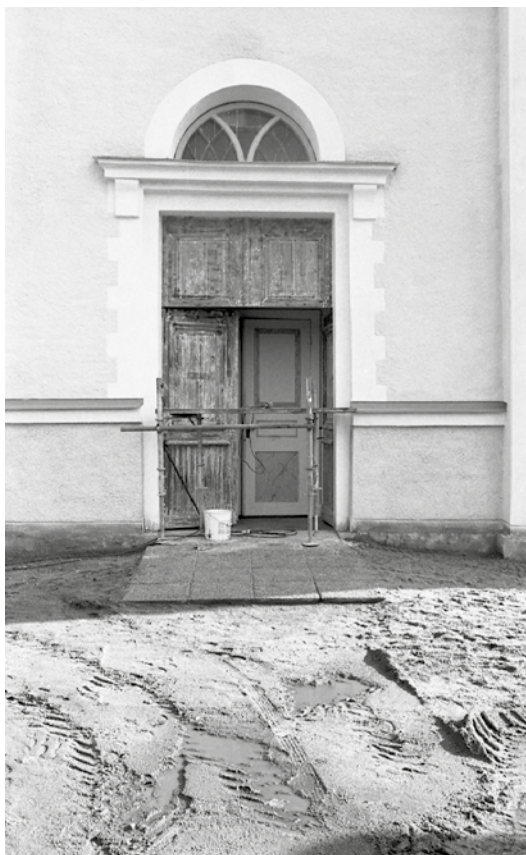
Pågående målning av sydportalen.
