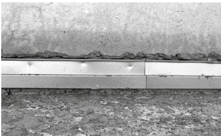
Ny plåttäckning i anslutning till tornets mittelbandlist.
