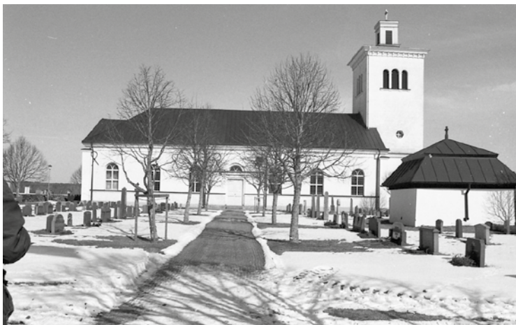
Kyrkan före åtgärd.
