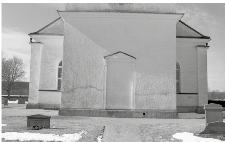
Tornets östfasad före åtgärd.
