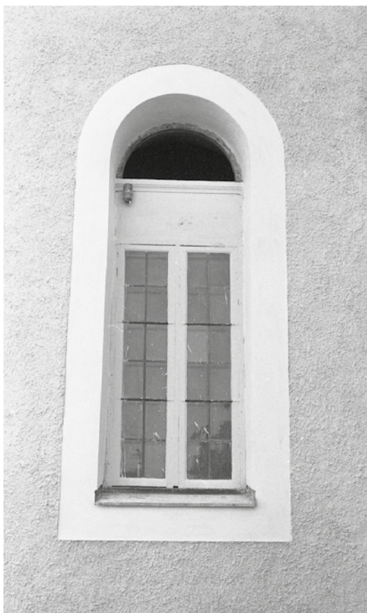
Målat fönster, överfönstret ännu ej återmonterat.
