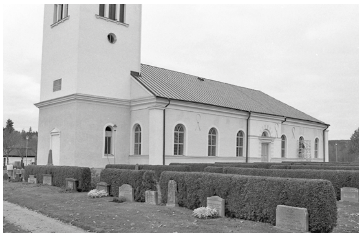
Tornet och norra fasaden från nordost.
