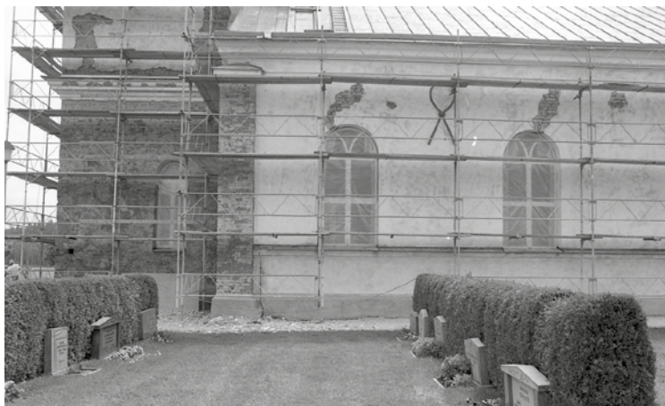
Tornet och norra fasaden under pågående arbete. Putsen på tornets nedre del är nedknackad och sprickor över långhusets fönster likaså.
