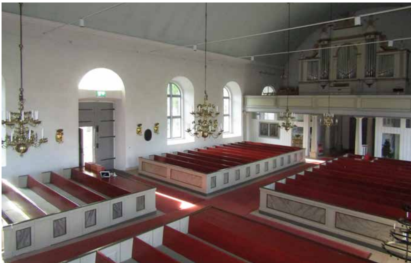
Översikt som visar kyrkorummet inför arbetena.
