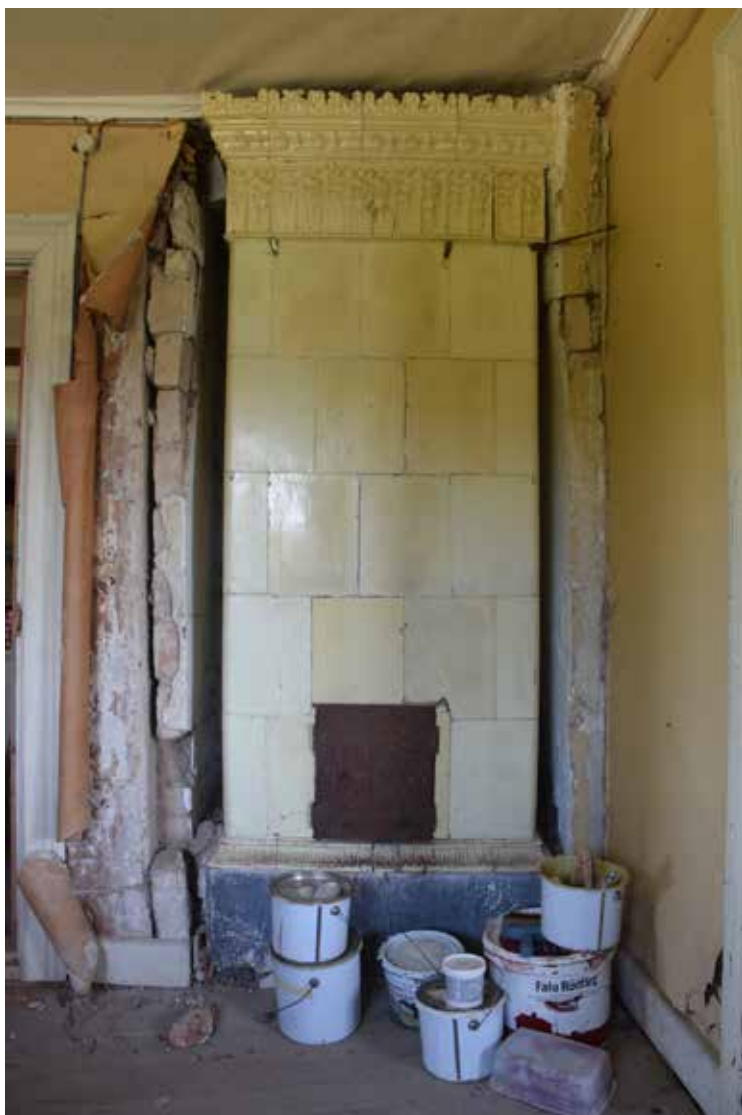
En av de två hantverksmässigt tillverkade gulglaserade kakelugnarna
