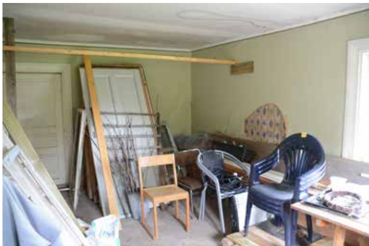
Rummet öster om hallen med de gröna pappspända väggarna.
