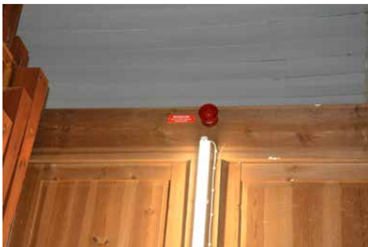
Brandsiren monterades på insidan av orgelhuset.
