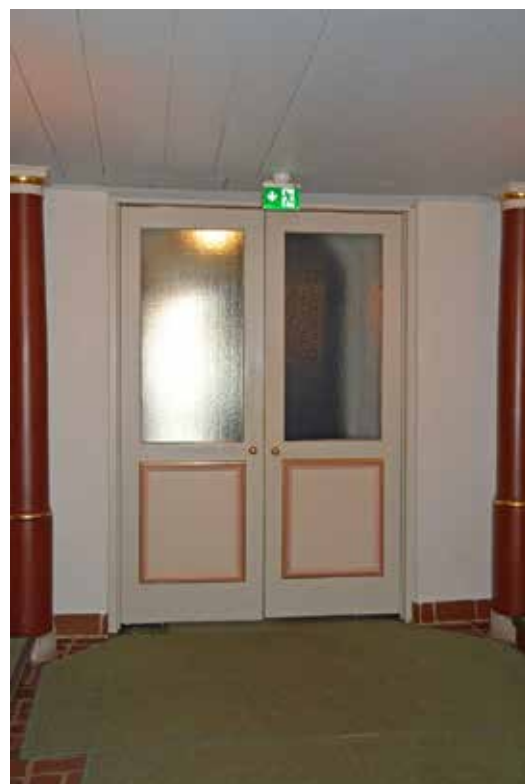
Utrymningsskylt vid dörrarna mot vapenhuset i väster.
