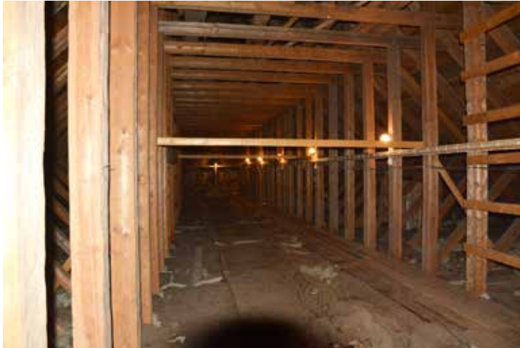
Vinden före installationen.
