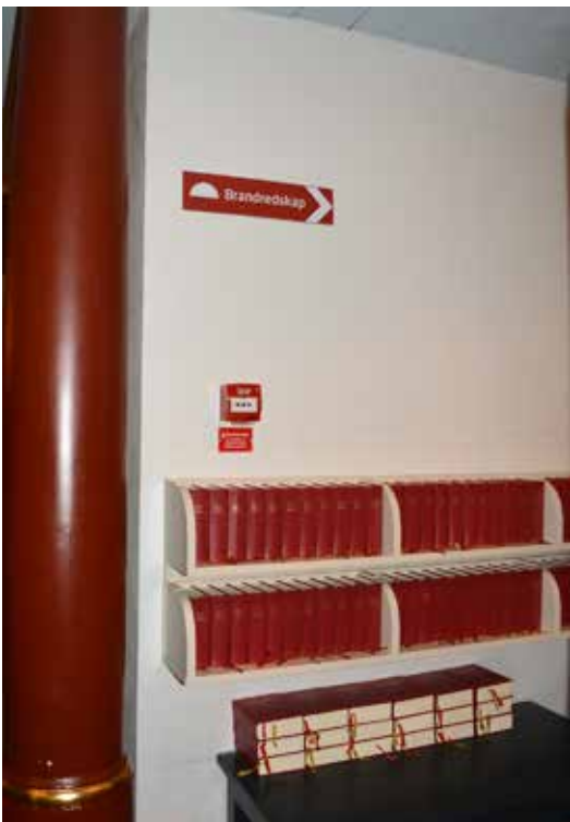
Larmdosan på den bakre väggen i kyrkorummet.
