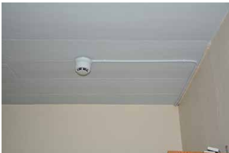
Detektorn i entrétaket under läktaren gick att montera med osynlig ledningsdragning.
