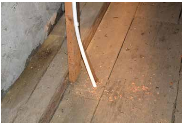
Enstaka håltagningar behövde göras för att kunna installera detektorerna i tornet.
