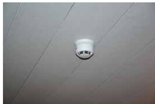
Detektorn i entrétaket under läktaren gick att montera med osynlig ledningsdragning.
