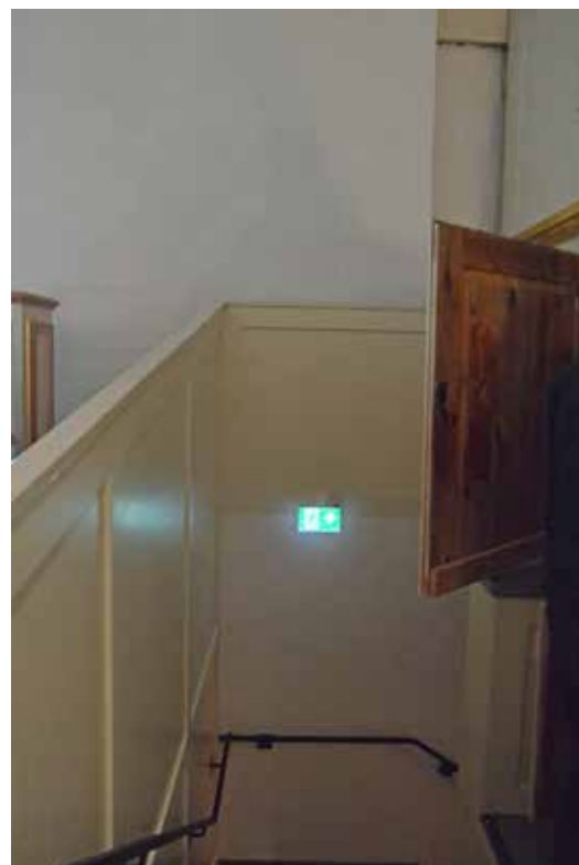
Utrymningsskylt från läktaren.
