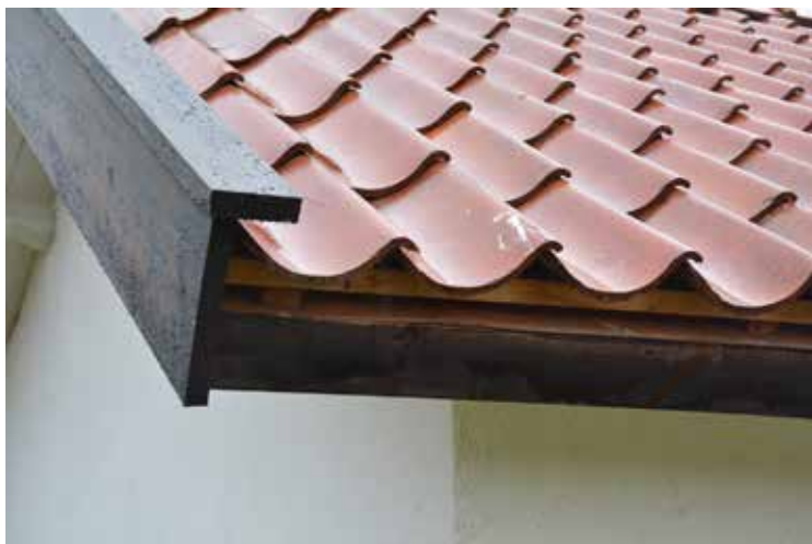
Detalj, tjärstruken vindskiva och lockbräda, vidare kan man ana masoniten under läkten.
