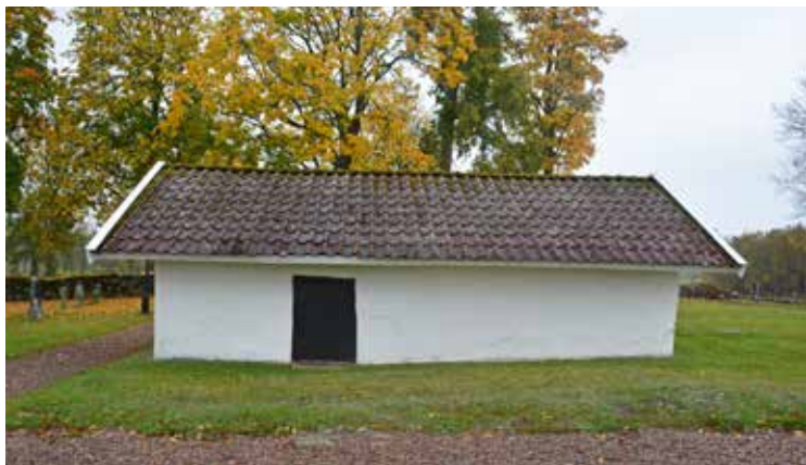
Gravkoret från söder före åtgärd.
