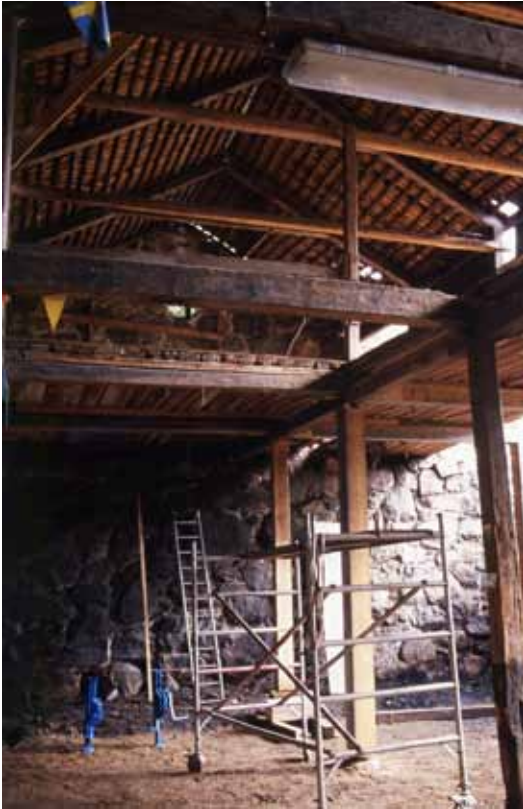
Ovan: Pågående arbeten i kolhusets norra del. Nya stolpar har rests och förankrats med dubbar i plintarna av natursten. Körbanan i det övre planet var ursprungligen avsedd för kolfororna.
