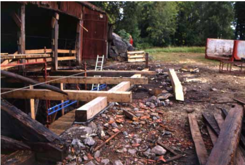
Nedan: Ny syll och nya bjälkar har lagts upp på stenmuren i östra långsidan. 2 september 2004.
