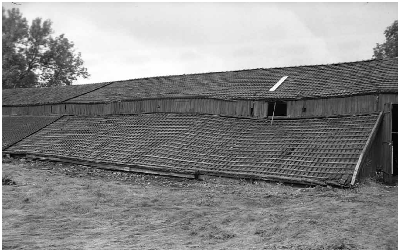
Nedan: Takyterna mot öster avtäckta, 17 augusti 2004. På övre takfallet låg enkupigt handslaget tegel, på det nedre cementpannor.
