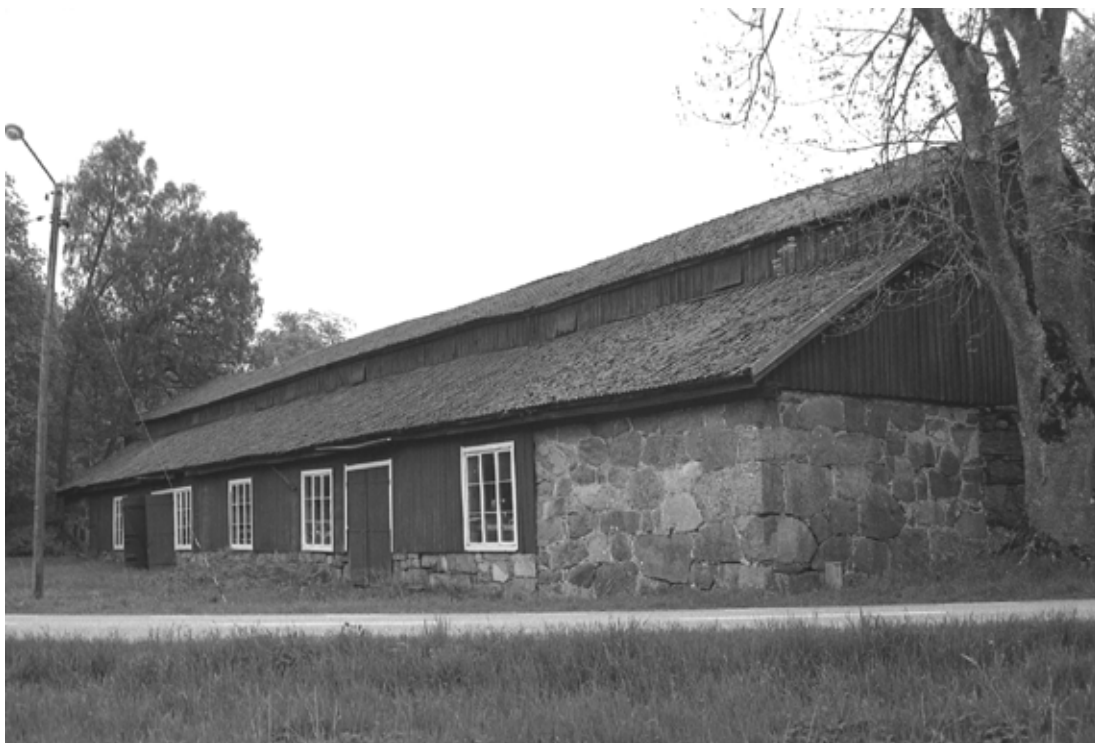
Ovan: Tegelladans fasad mot väster före restaureringen.
