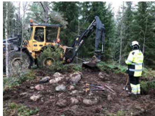
Figur 8. Avtorvning av L2020:8250, till en början med hjälp av grävmaskin.
