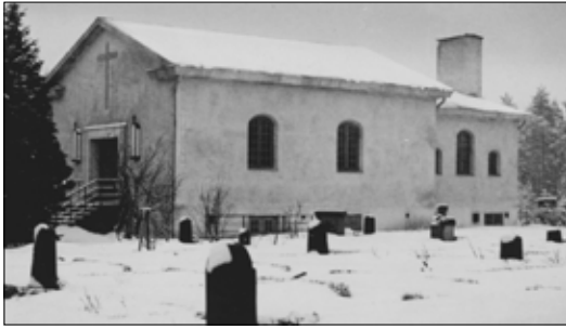
Kapellkrematoriet Uppståndelsekapellet före tillbyggnaden av vapenhusdelen i öster.
