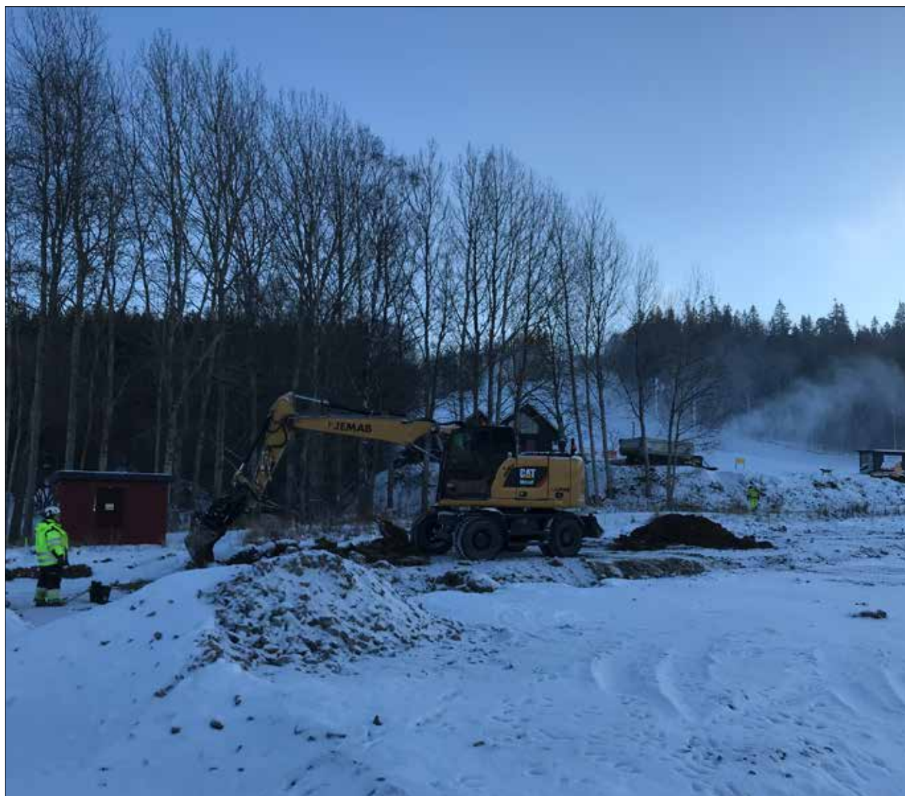
Figur 5. Avbaning av den östra delen av parkeringsplatsen 6 december 2021.
