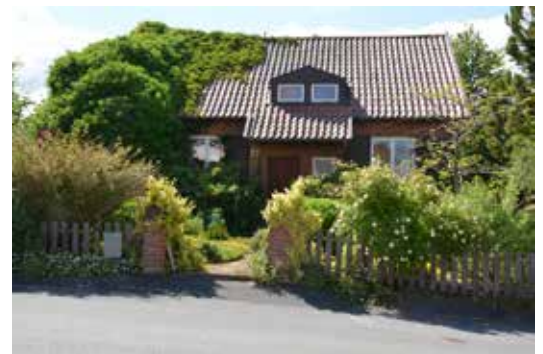
Bränninge 2:59 uppfördes 1954 efter ritning av Helmer Flensborn.
