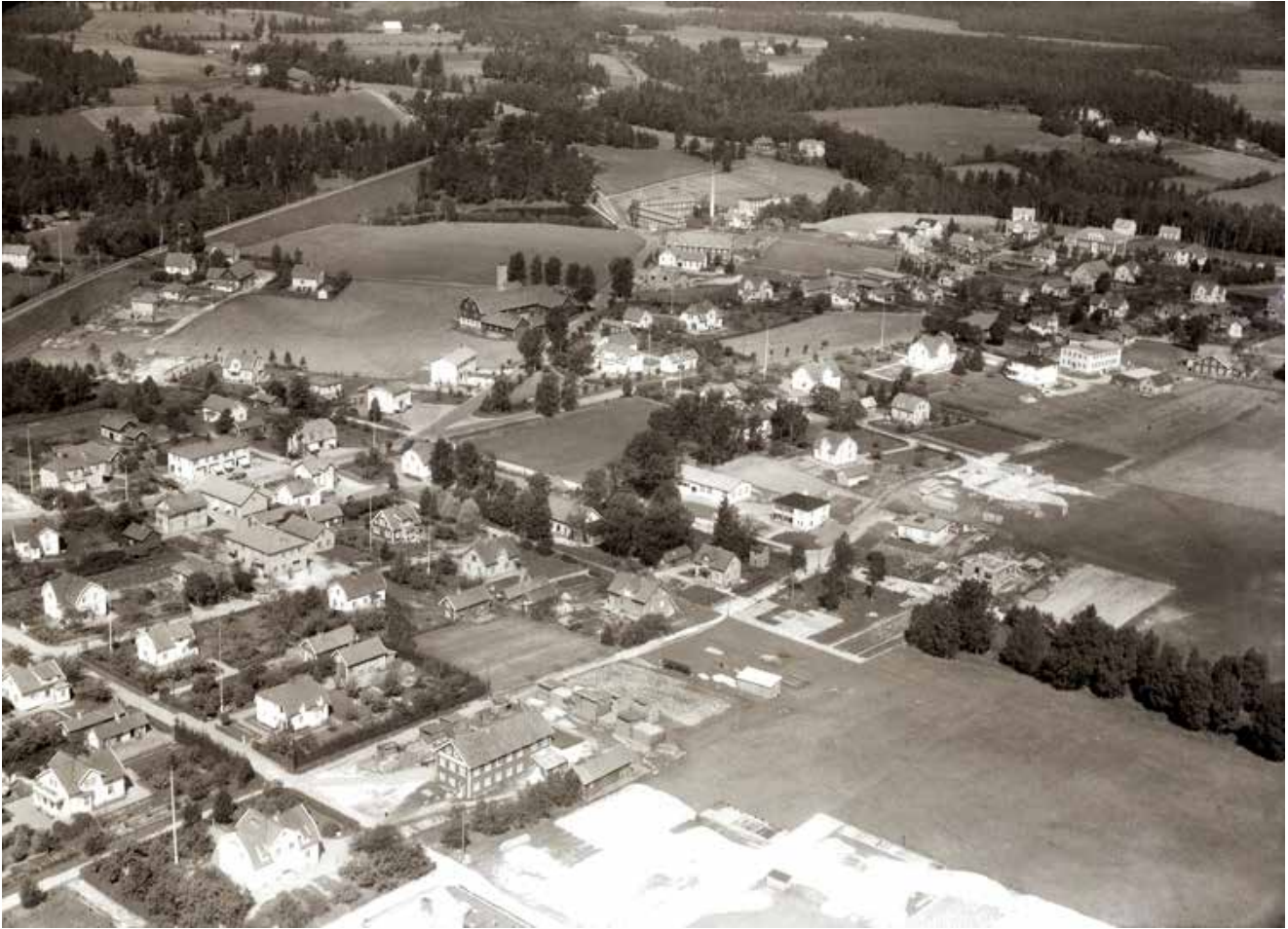
Flygbild från 1947, tagen från sydöst. Det är Villagatan och Skolgatan som möts i bildens nedre vänstra hörn. I förgrunden syns Bränninge 2:118 och till höger den snickerifabrik som fastighetsägaren drev. Fotografiet från Västergötlands museums samlingar på DigitaltMuseum.
