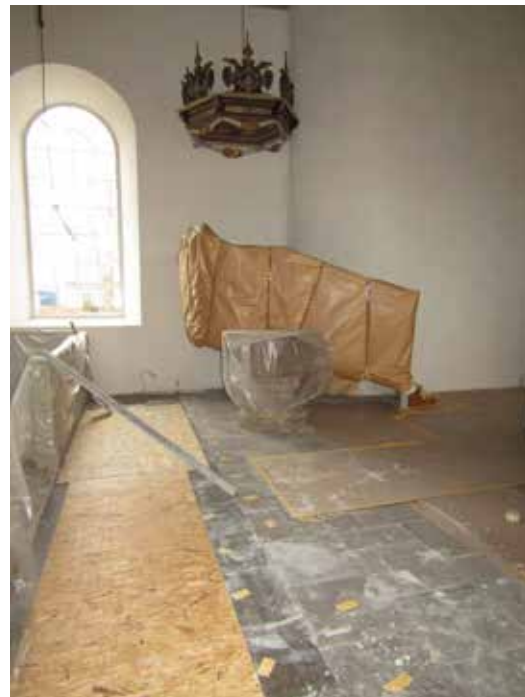
Ovan: Omläggning av delar av kalkstensgolvet pågår. Till vänster: Mötet mellan kalkstensgolv och nyslipat och hårdvaxoljabehandlat brädgolv. Mattan är specialkomponerad med utgångspunkt i kyrkorummets färgsättning.
