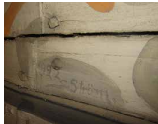
Målarmästare Svens Ströms signering i taket.
