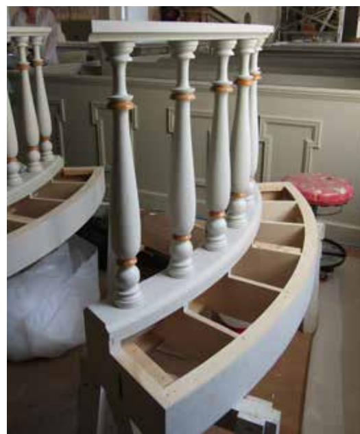
Ovan: Altarringen under montering och målning. Till vänster: Den nya altarringens placering provas.
