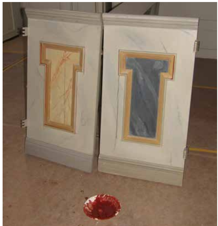
Denna skärm har sannolikt varit en av den tidigare läktarens barriär. Den krokiga kanten till vänster har sannolikt stött mot en yttervägg med ett ojämnt putsskikt.
