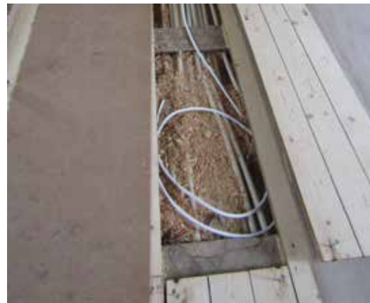
Sedan tidigare arbeten fanns det förberedda stråk i brädgolvet som med lätthet kunde öppnas upp.
