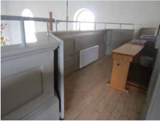
En ny stålörörsförhöjning placerades på läktarbarriären för att höja säkerheten.
