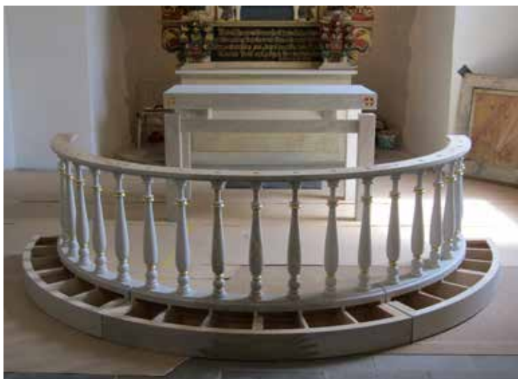
Ovan: Altarringen under montering och målning. Till vänster: Den nya altarringens placering provas.
