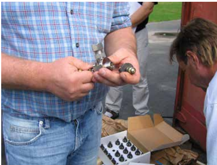
Besiktning av sprinklerhuvudena till Hi-Fog-systemet.
