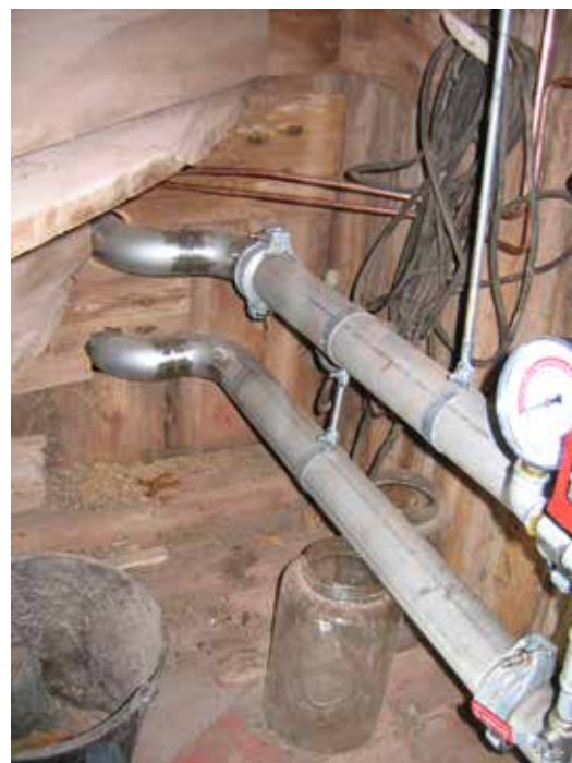
Ovan och till vänster: Central för sprinklersystemet för klockstapeln inordnades i ett förrådsutrymme under torntrappan.
