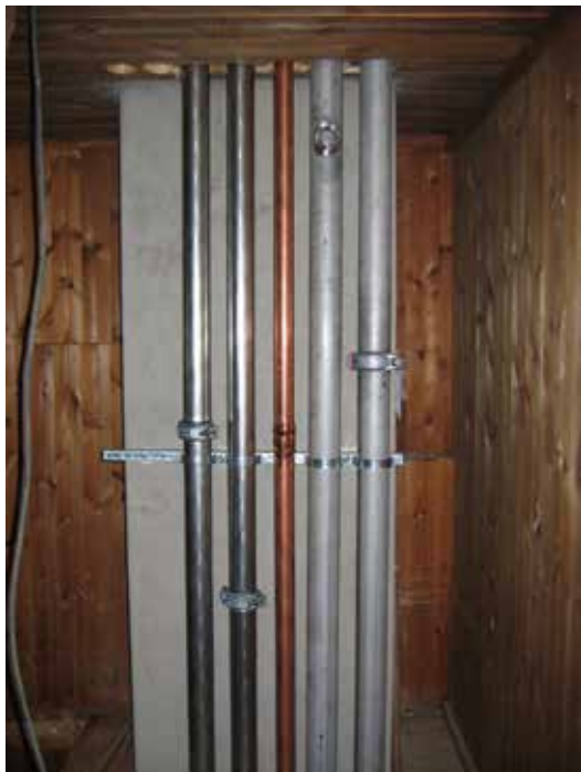
De vertikala matarrören monterades vid sidan om den gamla murstocken i det östra trapphuset.
