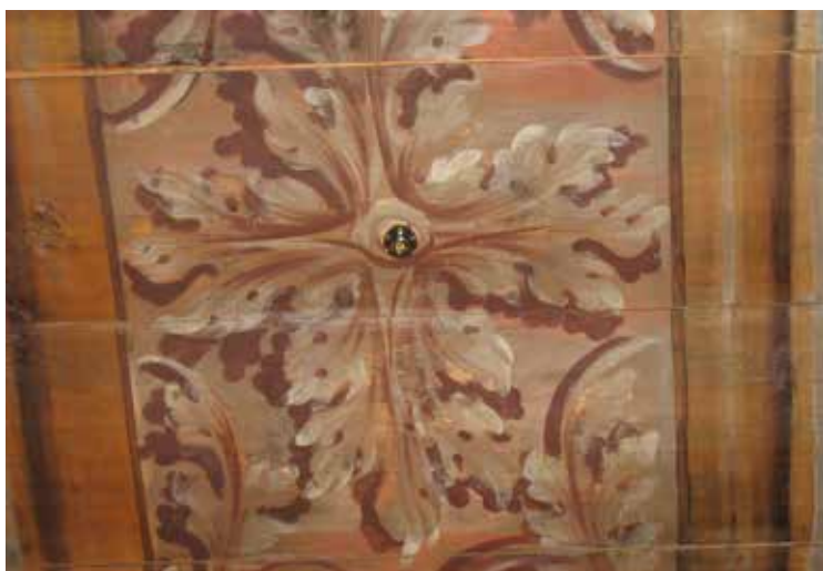
Sprinklermunstycke under sidoläktaren.
