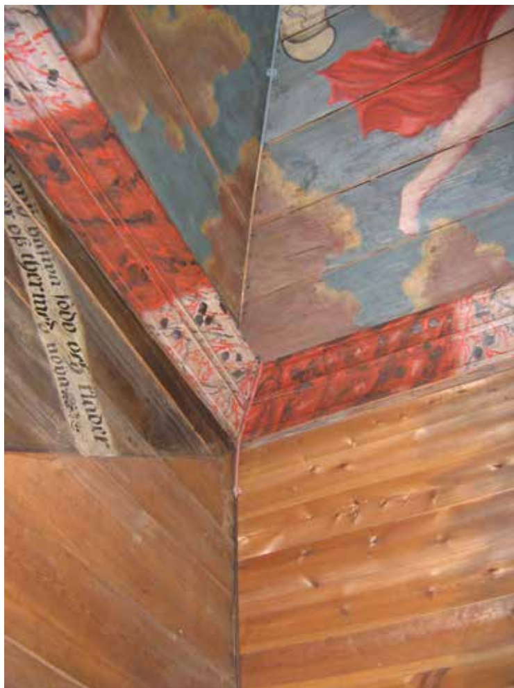
Över orgeln gick det inte att montera från vinden utan rören drogs synligt i vinkeln och målades mot underlaget.
