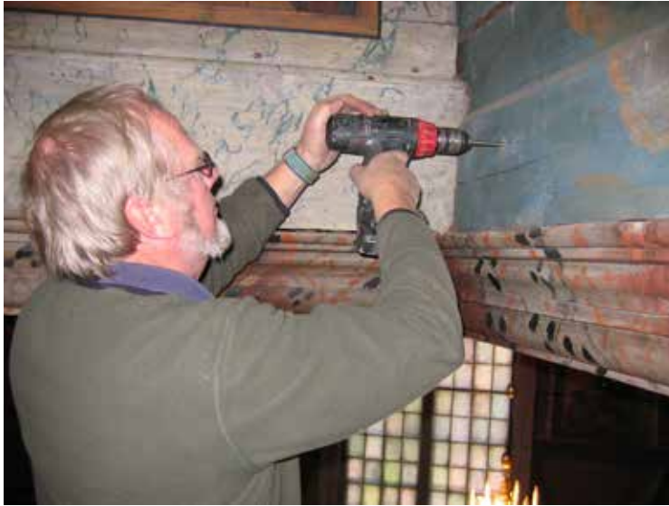
Pågående borrarbete för ett av de utstickande sprinklerhuvudena. Här gjordes borrhålen efter rörets storlek. Borrhålen plats i höjdläget fick anpassas efter hur bjälkarna låg. All borrarbete utfördes av Alf Andersson.
