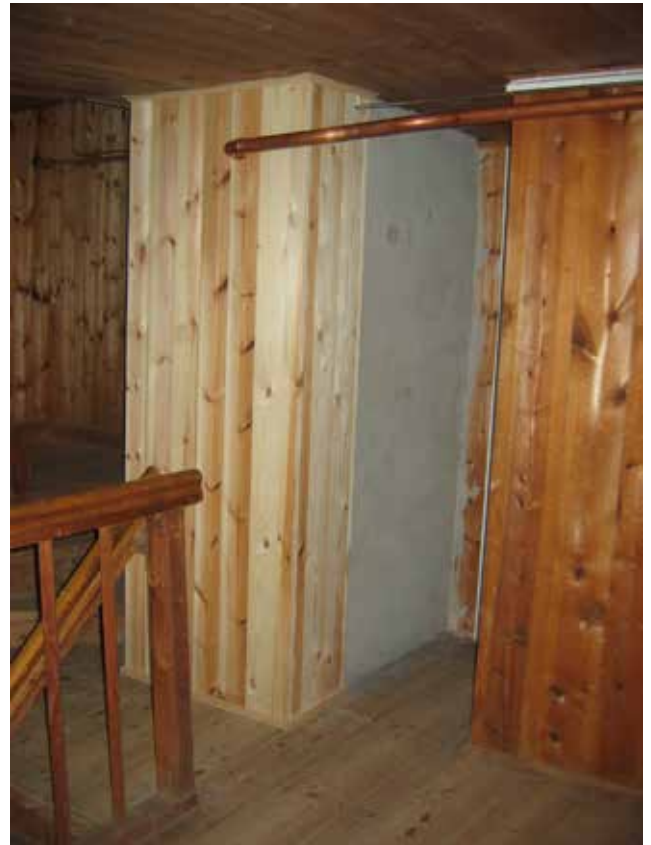
Inbyggnad av rörgatan, foto från maj 2006.
