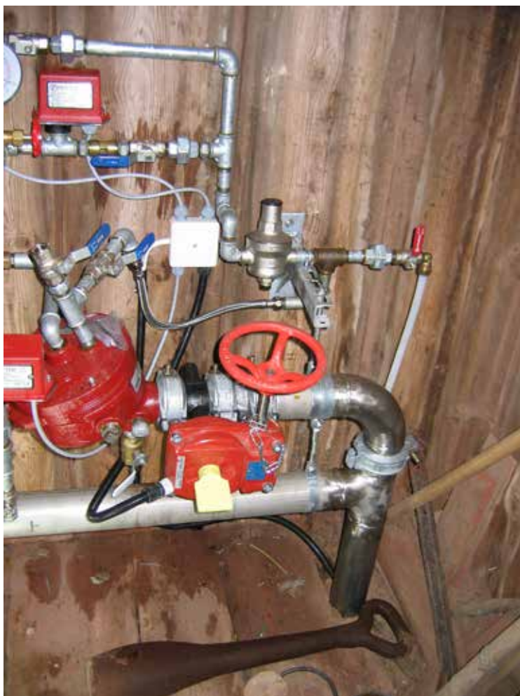
Ovan och till vänster: Central för sprinklersystemet för klockstapeln inordnades i ett förrådsutrymme under torntrappan.
