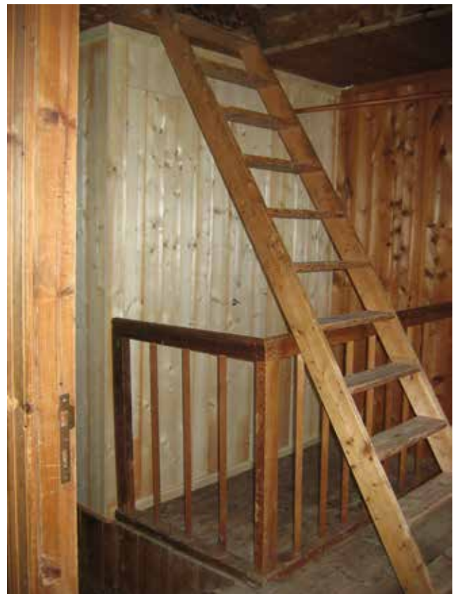
Efter avslutad installation byggdes rörgatan i trapphuset i öster in med panel. Övre planet, med trappstegen upp till vinden i förgrunden. Foto från maj 2006.
