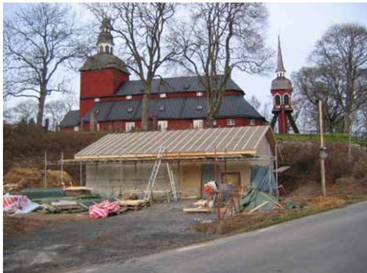
Teknikhuset under uppförande.
