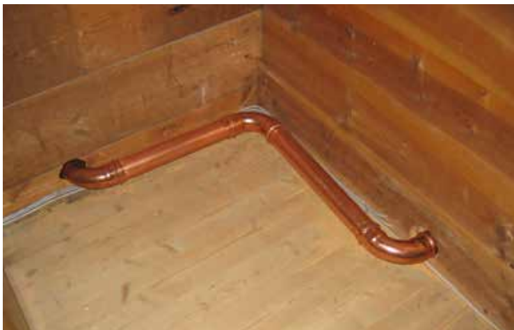
På läktaren vid sidan om orgeln var det inte möjligt att dra rören dolt utan de fick följa golv och vägg.
