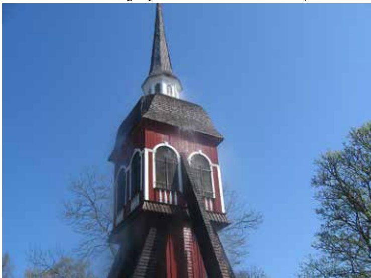
Ett fullskaleprov av sprinklern på klockstapeln utfördes i maj 2006.
