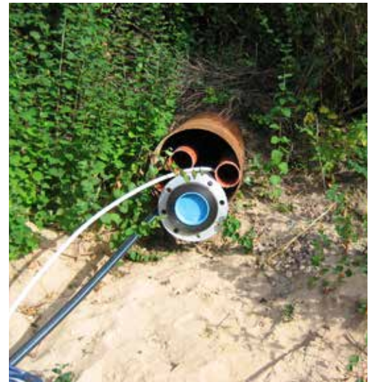
Kulverten med lagda rör för den kommande installationen.
