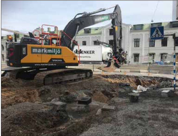
Figur 7. Schaktet med de många brunnarna i korsningen Klostergatan/Västra Storgatan.
