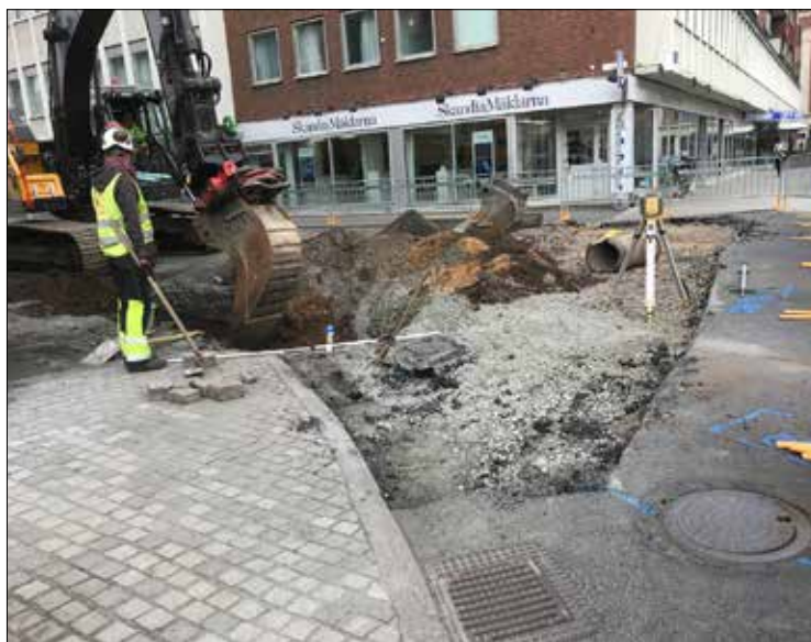
Figur 2. Schaktningsövervakning av område där äldre brunnar skulle ersättas av nya. Området visade sig vara helt utschaktat i samband med de tidigare brunnssnedsättningarna.
