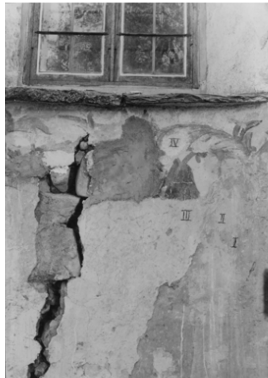
Putsstratigrafi på absiden, utförd 1938. Fyra skikt markerade varav nr III är det med renässansdekor och nr IV det med barockmåleri. Foto: Sven Wahlgren, ATA.
