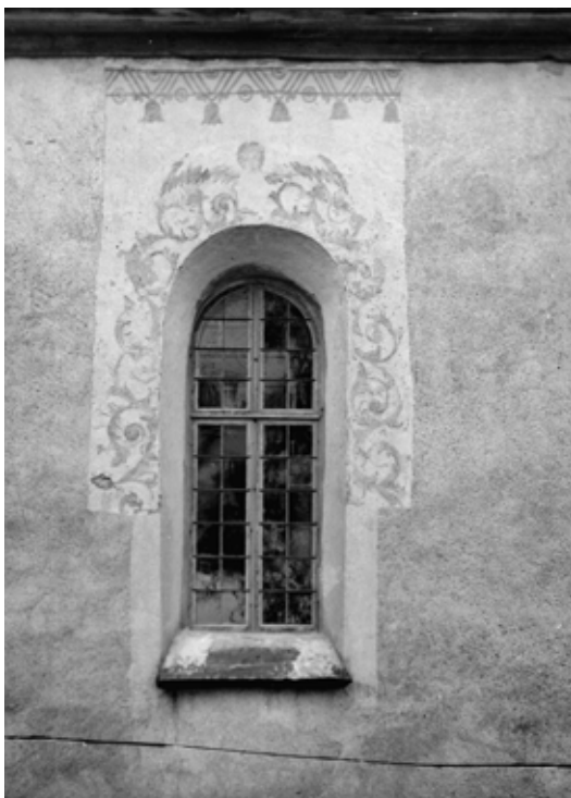
Renässansdekoren längs takfoten och barockdekoren kring ett av fönstren har här frilagts 1936. Arbetet med att ta ned hela det yttre skiktet av spritputs genomfördes 1938. Foto: Einar Erici, ATA.
