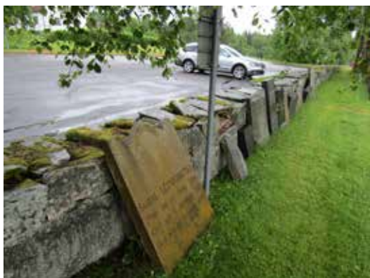
På krönet av muren norr om kyrkan ligger granithäl- lar, varav vissa är gravvårdar från sent 1600-tal och tidigt 1700-tal. Några borttagna vårdar står också lutade mot muren.
