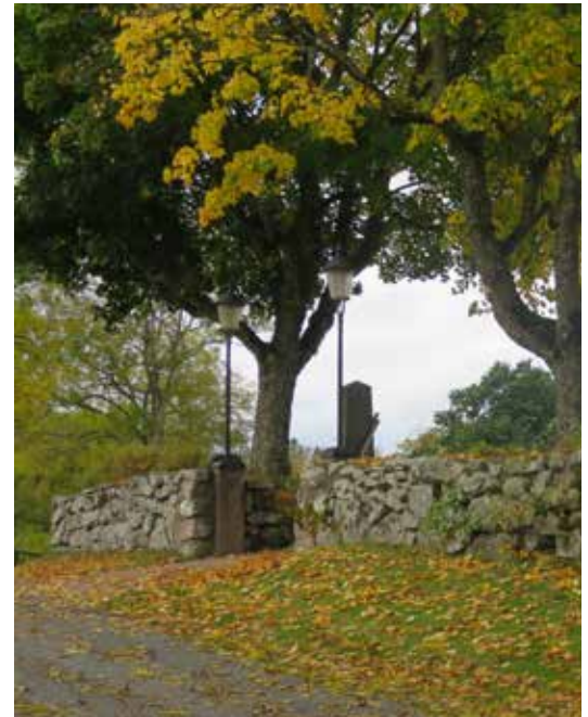
Södra ingången med grindstolpar i finhuggen röd granit infällda i muren. Smidesgrindarna från 1886 är avhängda för vinterförvaring.
