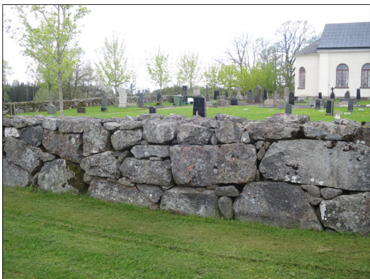
Kyrkogårdsmuren är enhetligt lagd av kilade granitblock, här syns östra sträckningen.
