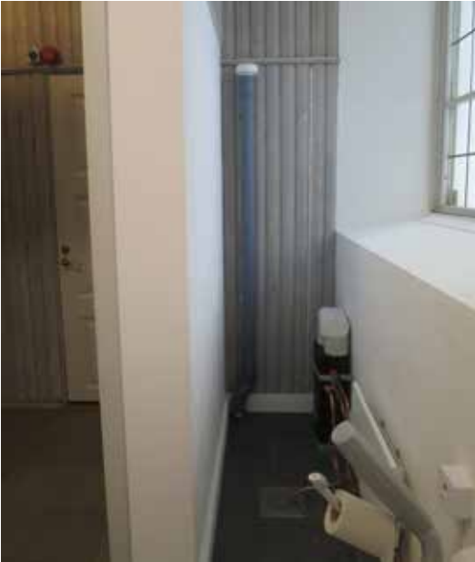
Varmvattenberedaren och tillhörande rördragning bör föras med en inbyggnad så att den inte blir lika iögonfallande.
