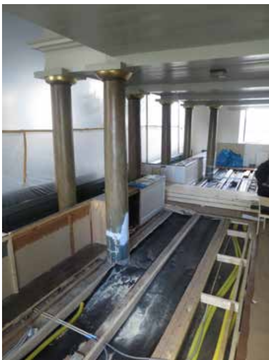
Ny eldragning förlades i golvbjälklaget. Befintliga golvbjälkar förstärktes och ytan försågs med nya golvbrädor.
