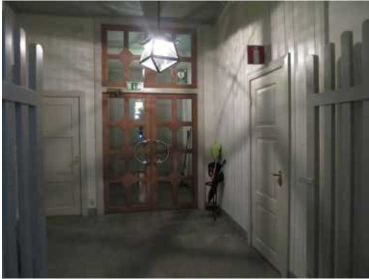
Vapenhusets panelklädda väggar och innerdörrar gavs en ny färgsättning.
