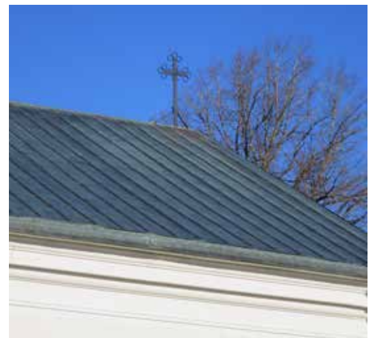
Detalj av södra takfallet före åtgärd. Koppartäckningen från 1962 var lagd som en skivtäckning med förskjutna tvärfalsar. Vid nocken sitter ett krönkors av gjutjärn.
