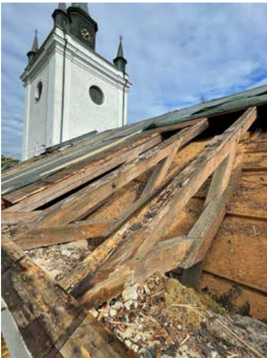
De flesta rötskadorna var lokaliserade till takstolarnas yttre delar, men flera takstolar hade även rötskador på ovansidan. Det förekom även mögelangrepp. Foto: Niklas Stangenberg
