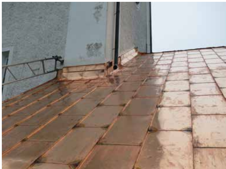
Samtliga stuprör har bytts ut. De nya stuprören har utförts med samma utförande som tidigare.
