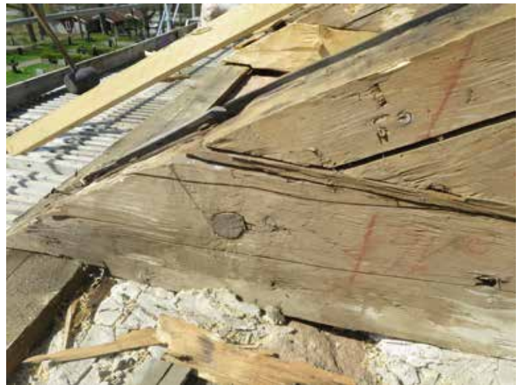
På takstolarna finns markeringar med röd krita, vilket tyder på att takstolarna förtillverkats på marken.
