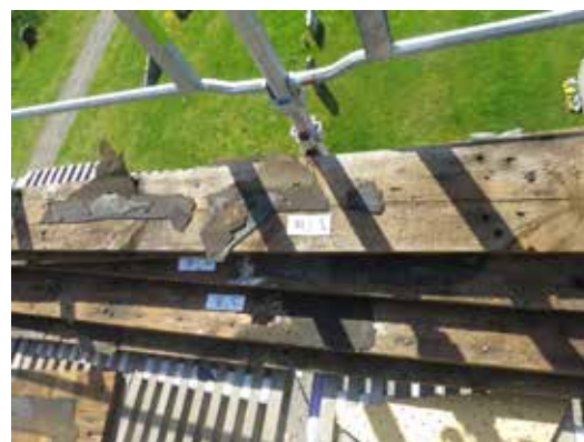
Äldre svallbrädor märktes upp och demonterades varsamt, för att efter åtgärd kunna återmonteras.
