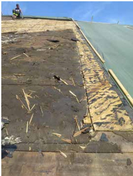
Ovanpå det äldre svallet ligger våder av den gamla papptäckningen kvar.
