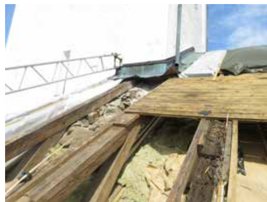
Nära tornet på det södra takfallet fanns en större lagning med taksvall från 1962 års takarbeten.
