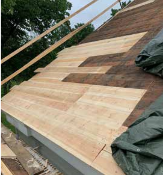
Skadat taksvall har ersatts med nya brädor av kärnfuru. Taksvallen har därefter täckts med perforerad masonit och underlagspapp. Foto ovan: Niklas Stangenberg
