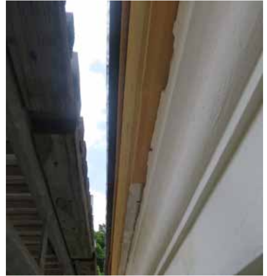
Takfotsbrädan och takfotslistens övre del av trä har bytts ut partiellt.
