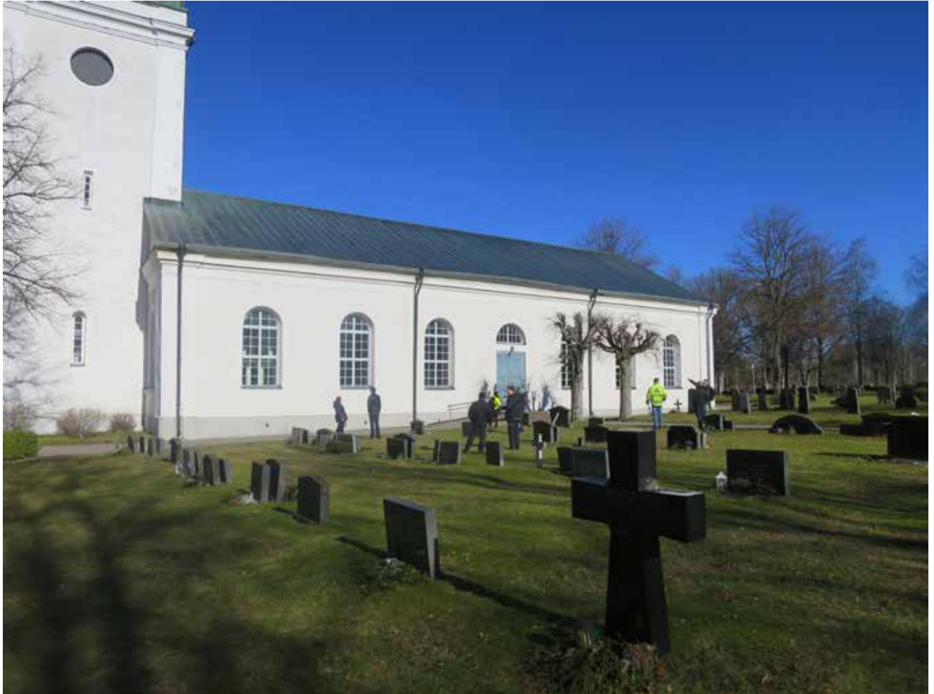
Hjälmseryds kyrka sedd från sydväst före åtgärd.
