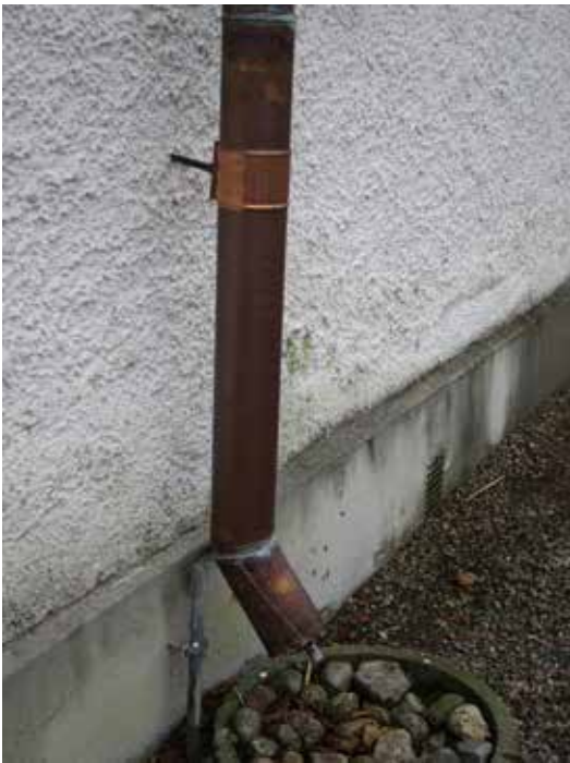
Samtliga stuprör har bytts ut. De nya stuprören har utförts med samma utförande som tidigare.
