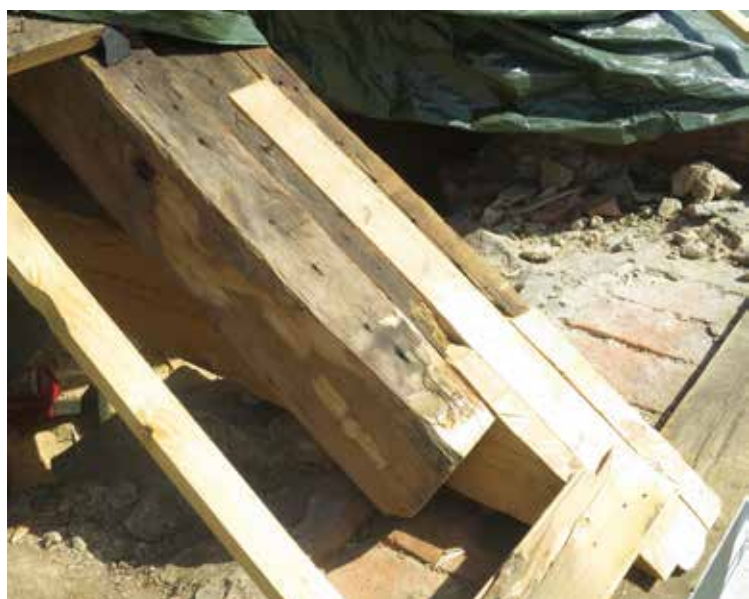
De flesta rötskadorna var lokaliserade till takstolarnas yttre delar, men flera takstolar hade även rötskador på ovansidan. Det förekom även mögelangrepp. Foto: Niklas Stangenberg
