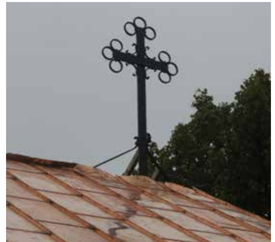
Krönkorset har rengjorts och strukits med järnmönja och svart linoljefärg.
