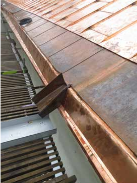
Ståndrännan har utförts med en stomme av trä och täckts in med kortare plåtvåder än tidigare.
