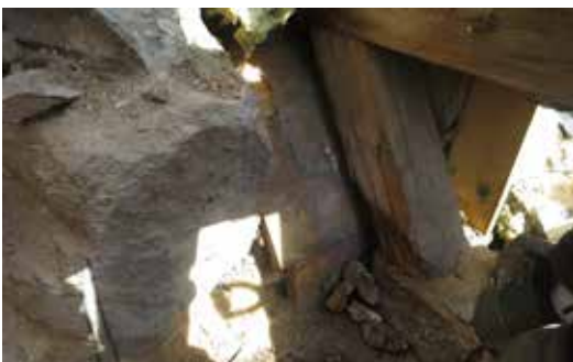
Taksvallen närmast tornet på det norra takfallet är antagligen återanvänd då den har spår av rödfärg.
