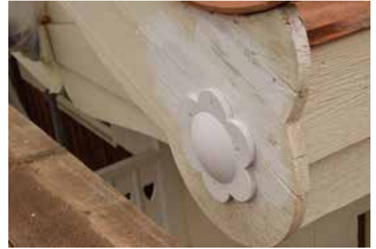
Detalj av entréverandans vindskiva där en av de dekorativa blommorna ersattes.
