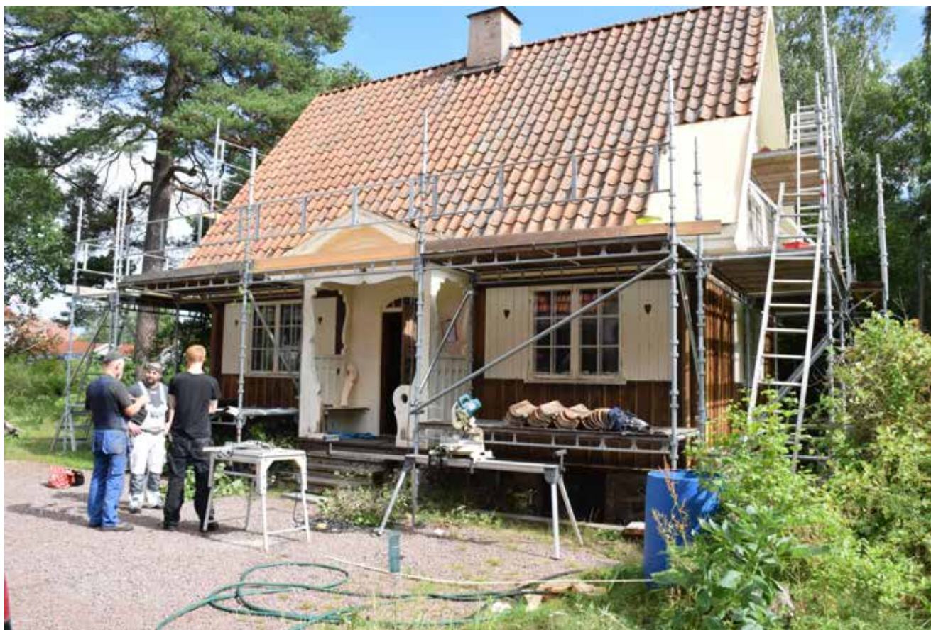
Under pågående arbete i augusti 2017.
