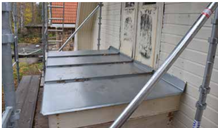
Balkongplattan försågs med en ny plåttäckning som drogs upp mot fasadpanelen likt tidigare utförande.
