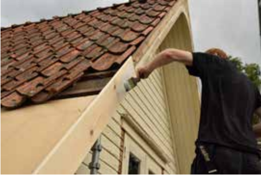
Samtliga utvändiga ytor som tidigare varit linoljefärgsmålade, rengjordes och målades åter med linoljefärg i en bruten vit kulör. Trärena ytor grundades först med slipstrykningsfärg.
