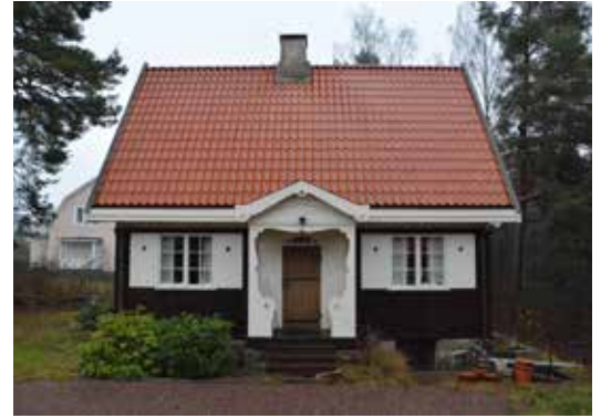
Lillstugan vid Villa Solvändan i Mariannelund efter restaurering.
