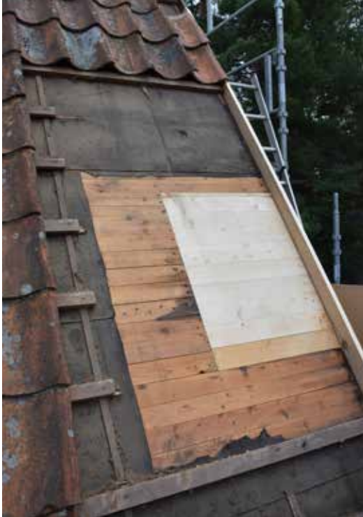
En mindre lagning av taksvallat gjordes på det nordvästra takfallet. Taket försågs med ny underlagspapp, och läkt samt enkupiga lertegelpannor.
