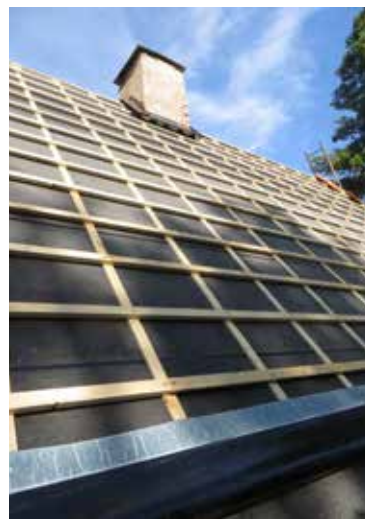
En mindre lagning av taksvallat gjordes på det nordvästra takfallet. Taket försågs med ny underlagspapp, och läkt samt enkupiga lertegelpannor.
