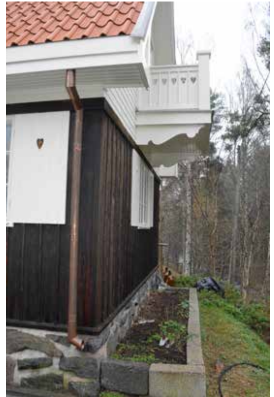
Balkongen försågs med ett nytt räcke som utformades lika det tidigare. Balkongdörrar, räcke och balkongplattans sidor samt undersida målades med vit linoljefärg.
