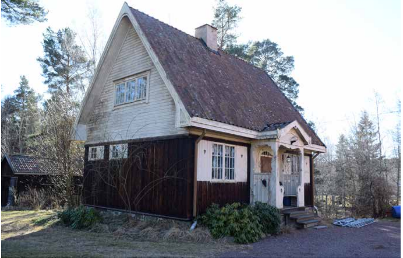
Lillstugan i februari 2017, före åtgärder.
