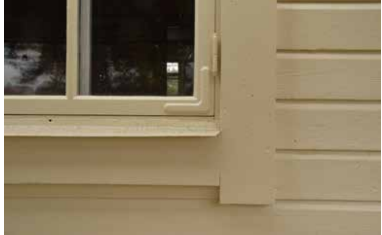
Samtliga utvändiga ytor som tidigare varit linoljefärgsmålade, rengjordes och målades åter med linoljefärg i en bruten vit kulör. Trärena ytor grundades först med slipstrykningsfärg.
