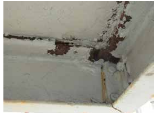
Ovan: Insidan av de bärande balkarna med ett bultat vinkeljärn.
