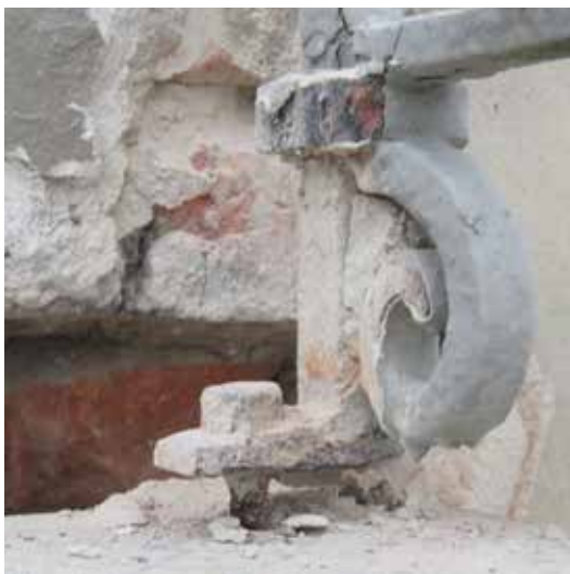
Ovan: En balkong när arbetena påbörjats. Nedan: Detalj av räcketts fäste mot balkonggolvet.
