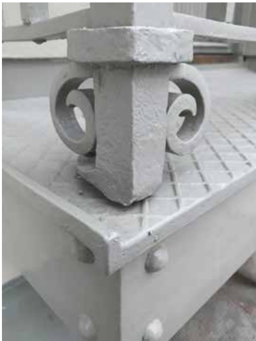
Ovan: Detalj av den modifierade golvplåten med avrinningslist på gaveln och droppnäsa på fronten. Ovan till höger: Det ilagade partiet med pålött rut-mönster.
