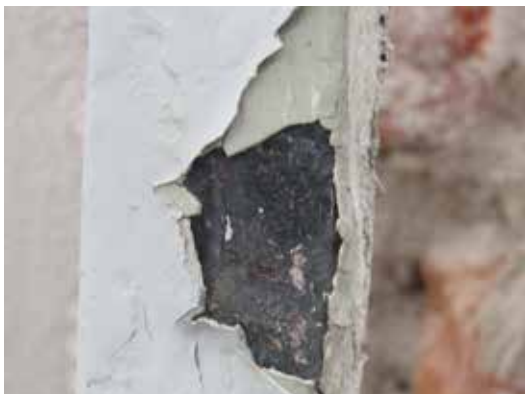
Detalj som visar bakomliggande skikt. Det grönaktiga är troligen den kulör som användes fram till restaureringen på 1990-talet. Den svarta är troligen en rostskyddande färg.
