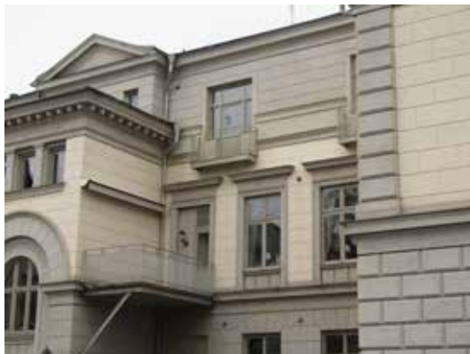
Balkongerna på håll efter att ställningen rivits.
