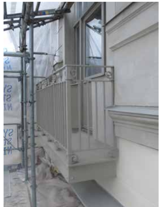
Ovan: Den färdigställda balkongen.
