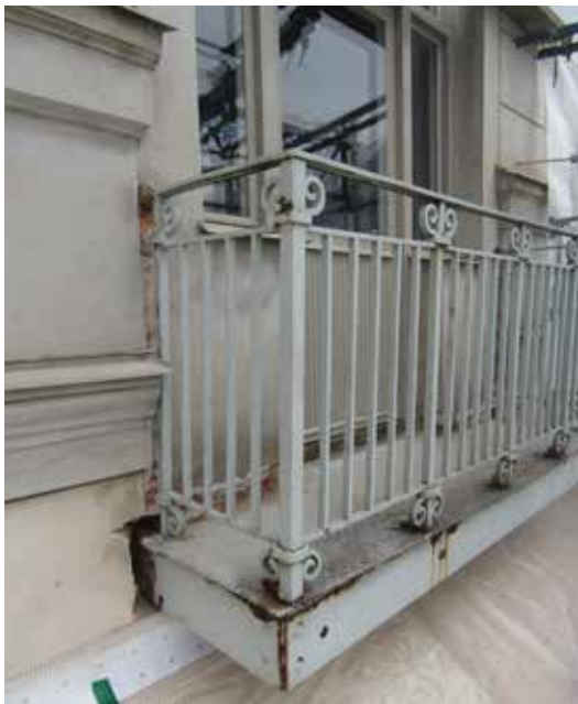
Ovan: En balkong när arbetena påbörjats. Nedan: Detalj av räcketts fäste mot balkonggolvet.
