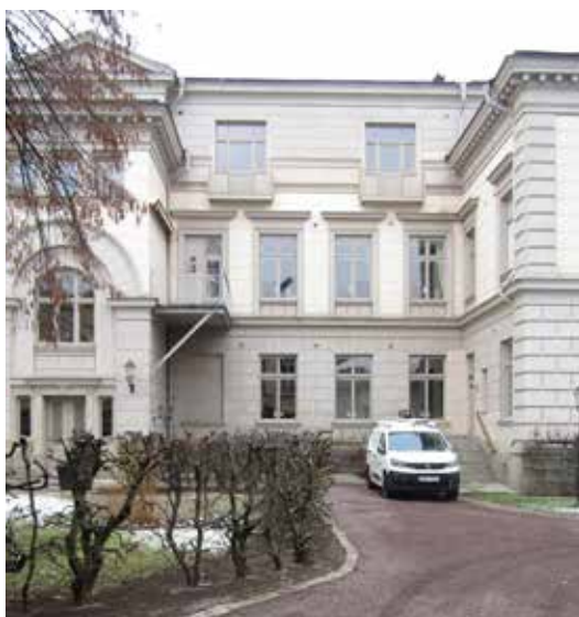
Den södra fasaden med balkongerna efter restaureringen.
