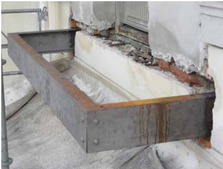
Ovan: Insidan av de bärande balkarna med ett bultat vinkeljärn.
