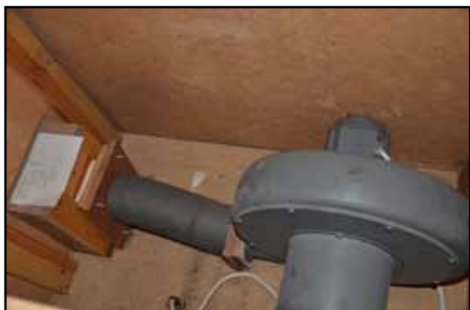
Elektrisk orgelfläkt, samtida med orgeln. Placerad i brandfarlig låda invid läktarens västvägg.
