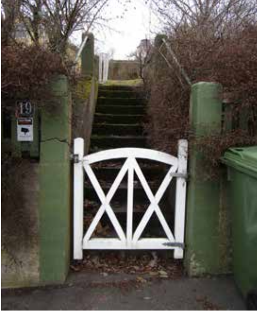
Ovan: Tomten Tranan 9 nås via en betongtrappa från Mäster Gudmunds väg. Till höger: Tranan 9 sedd från Mäster Gudmunds väg. Till höger på bilden skymtar den mindre förrådsbyggnad som finns på tomten.
