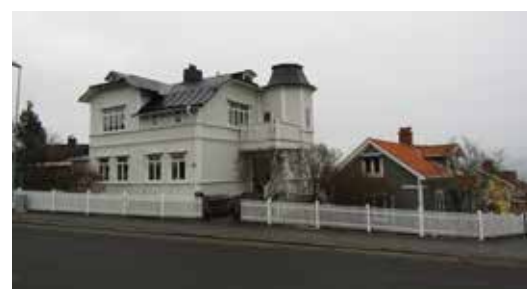
De två bostadshusen på Tranan 8 är uppförda kring sekelskiftet 1900.
