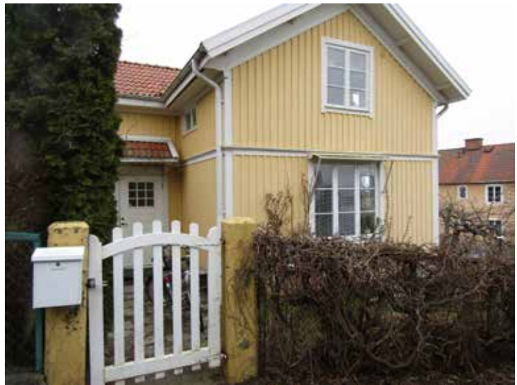
Bostadshuset på Tranan 11 i februari 2023. Till vänster skymtar den tillbyggnad inrymmande trapphus som uppfördes på 1930-talet och som förstörades på 1990-talet.
