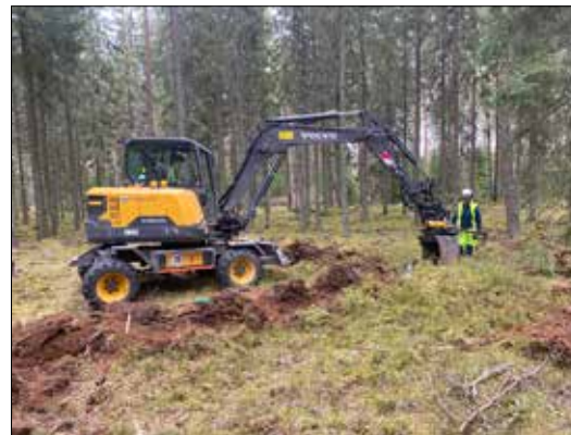
Figur 2: Kristina övervakar maskinschaktningen
