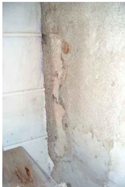
Ett mindre parti av en äldre fasadputs upptäcktes i samband med arbetena. Putsen gick in bakom tornet och är därmed sannolikt äldre än tornet, vilket uppfördes 1784. Foto: Leif Roos.
