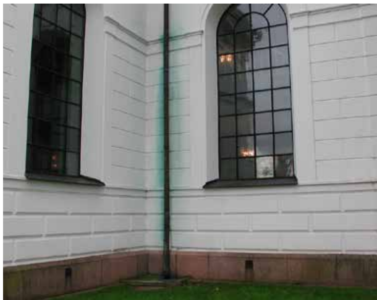
Andra skador som förekom var ärgfläckar i anslutning till stuprör och mindre sprickor i anslutning till plåttäckningar. Foto höger: Spina.
