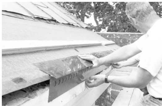
Den putsade taklisten fick bitvis huggas ned till putsbärare och därefter byggas upp på nytt. Takfoten försågs med nya luftningsbeslag. Foto höger: Leif Roos.
