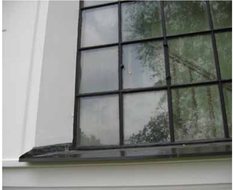
Det förekom kittbortfall och spräckta glas på kyrkans fönster. Fönstren kompletteringskittades, trasiga glas ersattes och bågarna rostskyddsbehandlades samt målades. Plåtavtäckningar justerades. Foto höger: Jonas Haas 2004.
