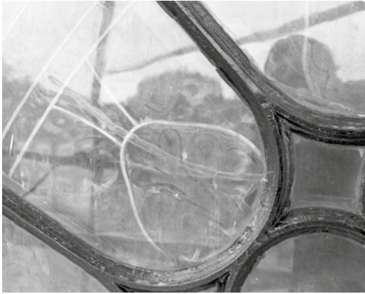
Det förekom kittbortfall och spräckta glas på kyrkans fönster. Fönstren kompletteringskittades, trasiga glas ersattes och bågarna rostskyddsbehandlades samt målades. Plåtavtäckningar justerades. Foto höger: Jonas Haas 2004.
