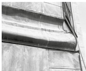
Lanterninens plåtbeklädnad var i behov av omtäckning. Lanterninens vulster var buckliga. Även partier av torntaket var bristfälliga.
