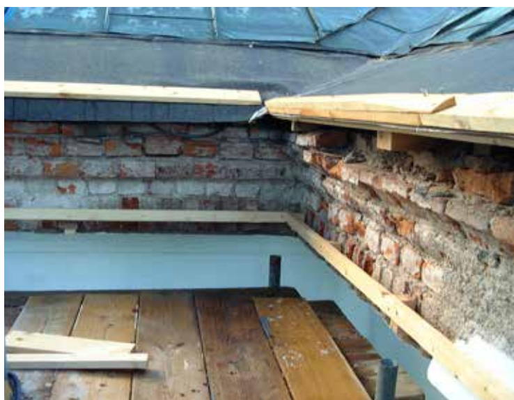
Den putsade taklisten fick bitvis huggas ned till putsbärare och därefter byggas upp på nytt. Takfoten försågs med nya luftningsbeslag. Foto höger: Leif Roos.
