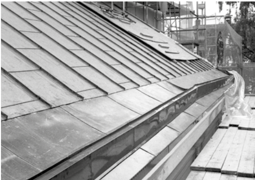
Samtliga fotrännor och fotplåtar byttes.
