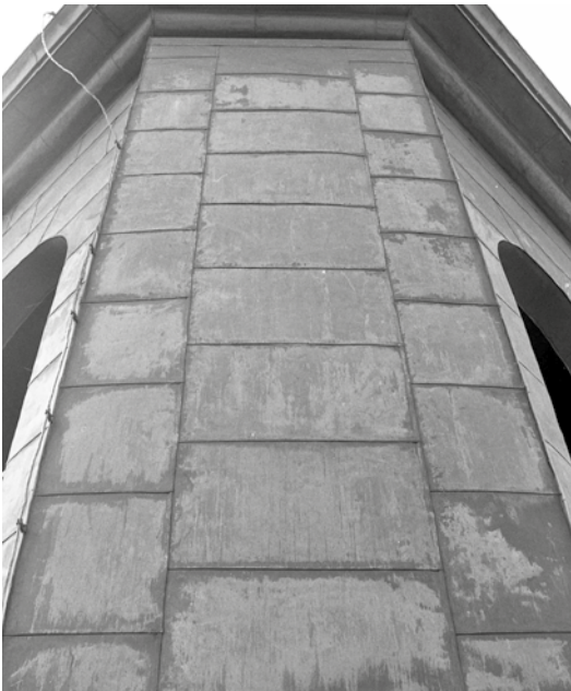
Lanterninens plåtbeklädnad var i behov av omtäckning. Lanterninens vulster var buckliga. Även partier av torntaket var bristfälliga.
