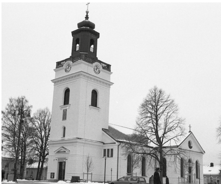
Den restaurerade kyrkan vid den antikvariska slutbesiktningen i december 2002.
