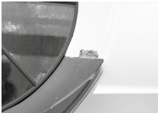
Andra skador som förekom var ärgfläckar i anslutning till stuprör och mindre sprickor i anslutning till plåttäckningar. Foto höger: Spina.
