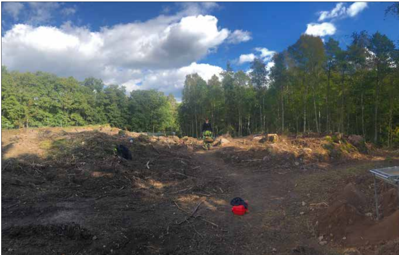
Figur 7. Översiktsbild över den sydligaste delen av undersökningsområdet, vilken utgjorde en uddliknande formation intill ett mindre vattendrag omedelbart nedanför udden. I bildens förgrund ses den traktorväg som avgränsade undersökningsområdet i väster. Dessutom anas även ett mindre sadelläge inom vilket merparten av de påträffade fynden låg.
