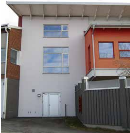
Detalj av den västra fasaden och mötet mot matsalsbyggnaden.
