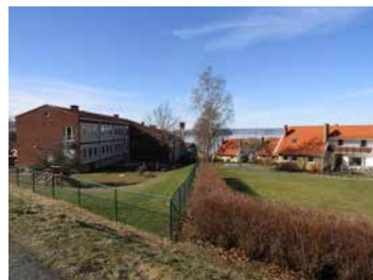
Till höger ses några av radhusen i bostadsområdet Norrängen som stod klara två år innan skolan uppfördes.
