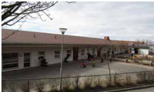
Byggnadens östra fasad som vetter mot skolgården är betydligt lägre och har ett mer diskret utförande.
