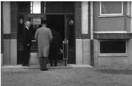
Detalj av småkolans entré med teakportar. Notera burspråkens karosseripanel. Fotot är hämtat från filmen "Norrängsskolan, del 2" filmad under 1953 och 1954 sedan skolan tagit i bruk, Jönköpings stadsarkiv.
