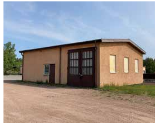
F.d. bensinstation med tvätt- och smörjhall uppförd 1953 utmed Centralgatan.
