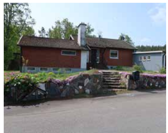
Villa från 1960-talet utmed Domängatan med bevarat originalutförande.
