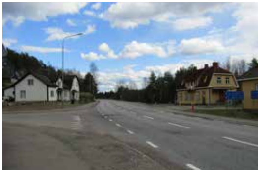
Riksväg 40 passerar genom det långsträckta samhället. På fotot ses stationshuset från 1912 till höger och en f.d. handelsbyggnad från sent 1800-tal.
