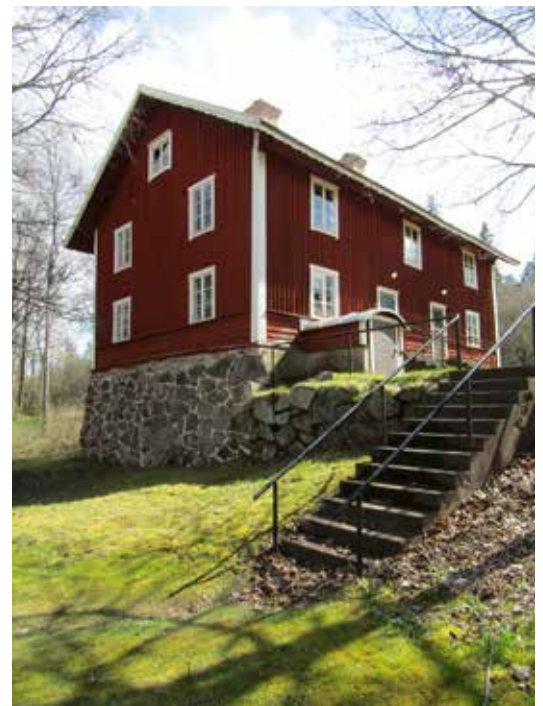
En av arbetsbostäderna i Smedbacken vid Bruzaholms bruk. Byggnaderna har viktiga originalvärden.
