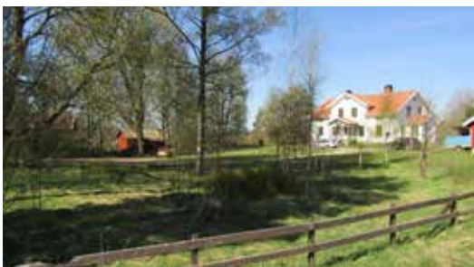
Prästgårdens mangårdsbyggnad och bodar finns ännu kvar.
