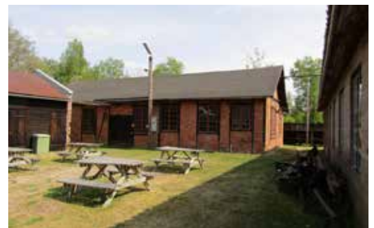
Julles verkstad i Mariannelund är en gjuteri- och verkstadsmiljö som är förklarad som byggnadsminne och därmed skyddad av kulturmiljölagen.
