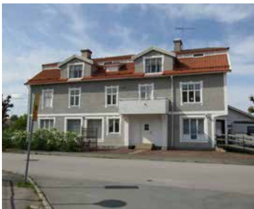
Många av de äldre byggnaderna i samhällets centrum revs under 1960- och 1970-talen. Det finns dock ett fåtal äldre affärs- och bostadshus bevarade inom området. Här ses en byggnad på Skolgatan.
