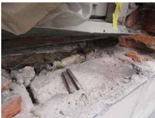
Tenar av järn och näver påträffades vid rivningen av tröskelplåtarna.
