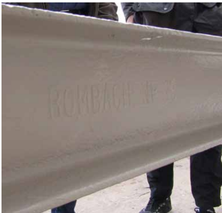
En av stålbalkarna märkta "Rombach nr 18" med hänvisning till det vid den tiden tyska järnverket i Elsass/Alsace.
