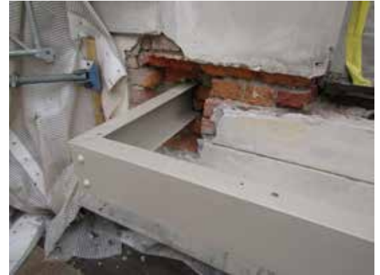
Detalj av den västra stålramen.
