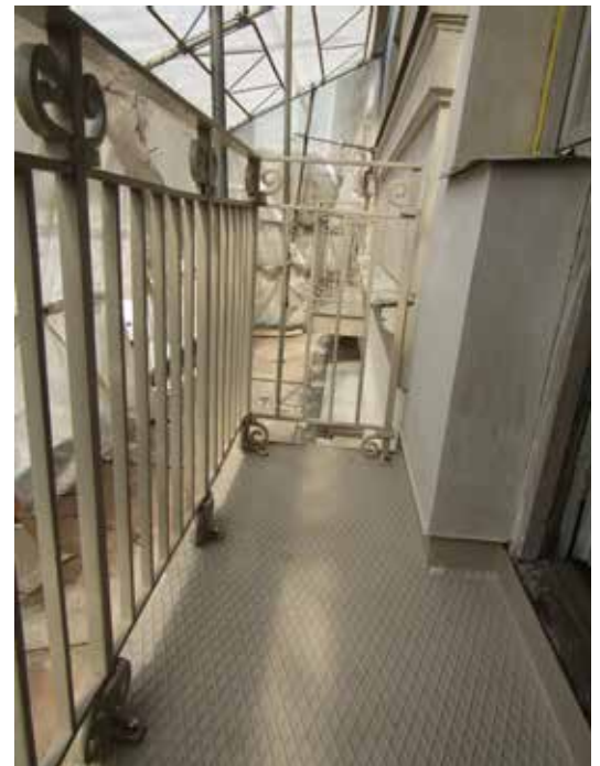
Insidan på den östra balkongen där durkplåten fick bytas. Rutmönstret här är mer rombiskt.
