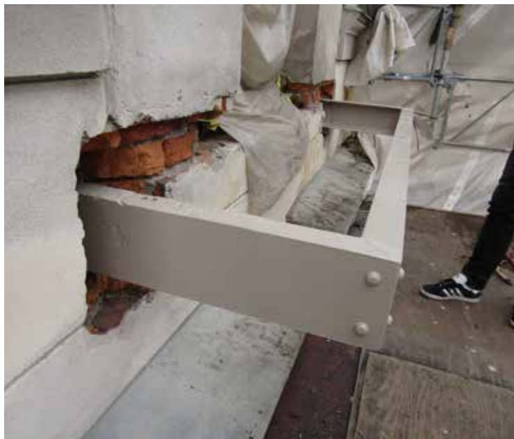
Det närmaste hörnet på denna stålram var så rostangripet att det fick ersättas, men skarvarna blev knappast synliga.
