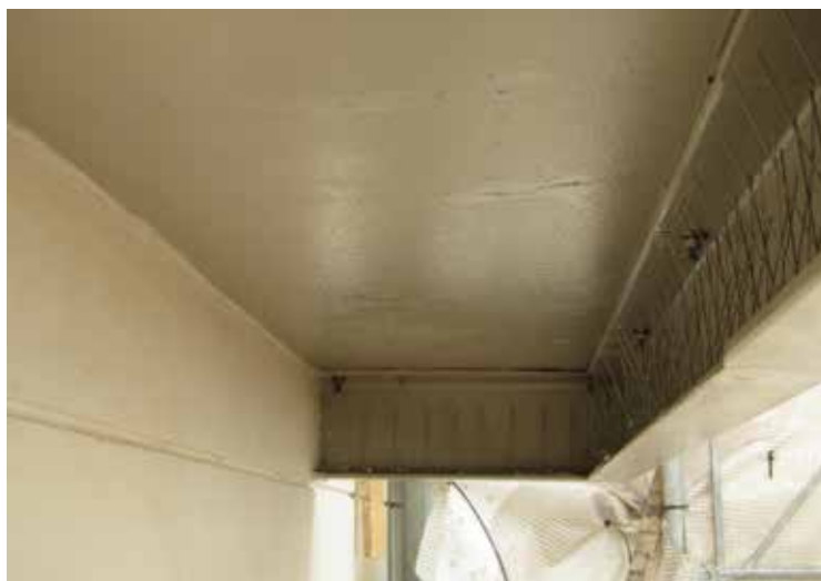
En balkongundersida med fågelband på balkarnas insidor.
