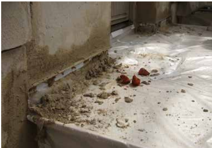
Här pågår putslagning där den uppvikta plåten ansluter med putskant.
